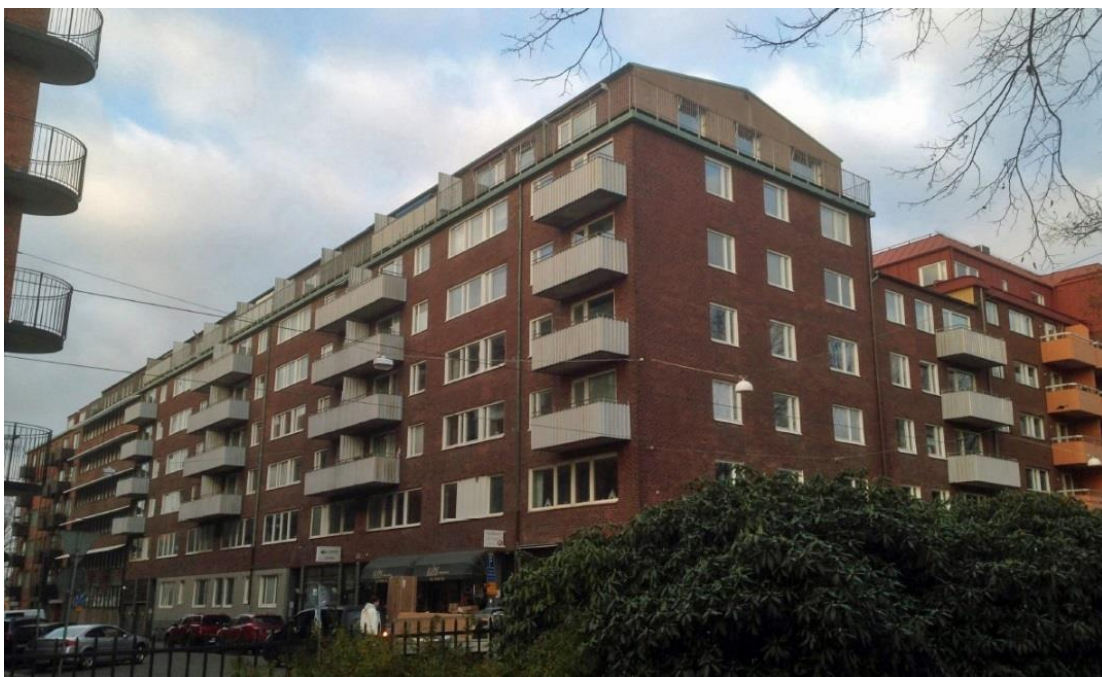
Befintligt utseende, hörnet Baldersgatan/Stampgatan (Krook & Tjäder)
