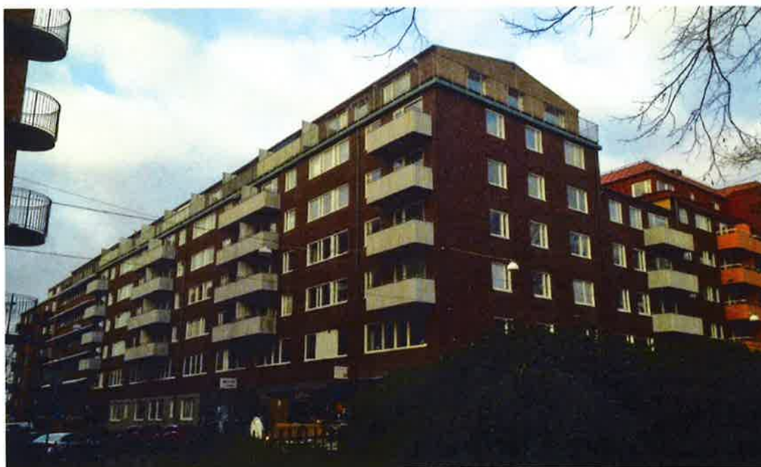
Befintligt utseende, hörnet Baldersgatan/Stampgatan (Krook & Tjäder)
