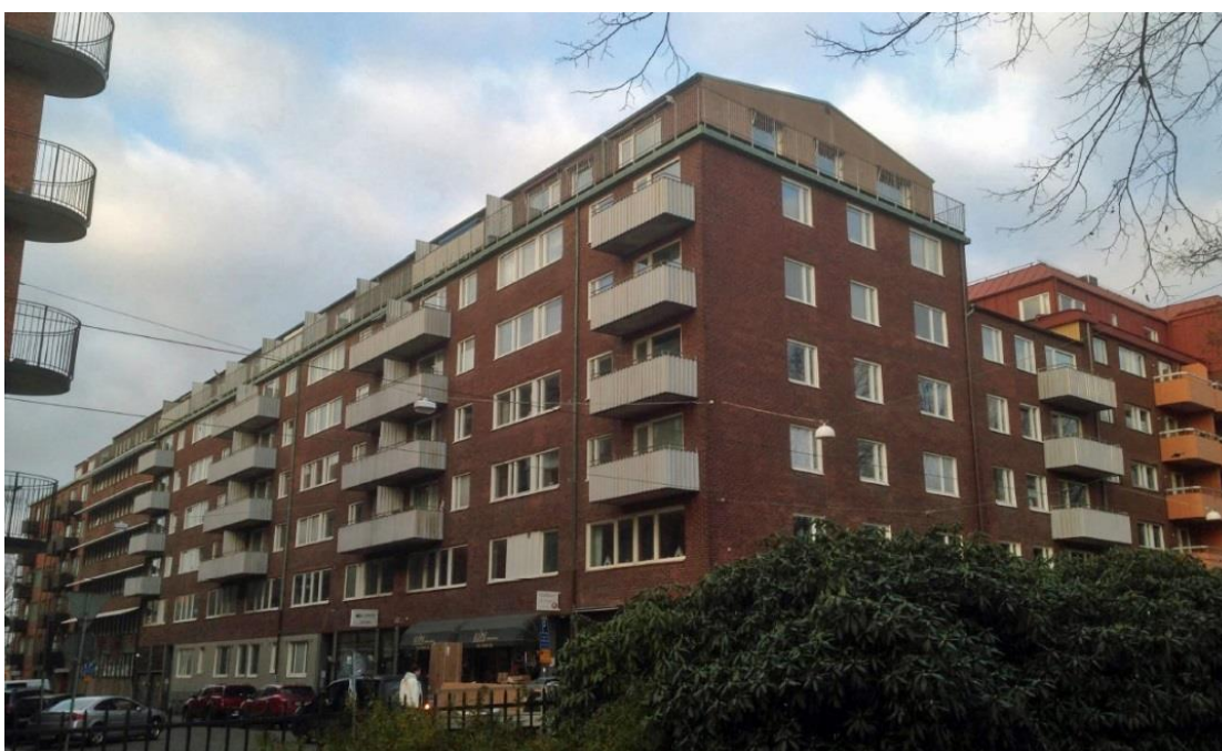
Befintligt utseende, hörnet Baldersgatan/Stampgatan (Krook & Tjäder)
