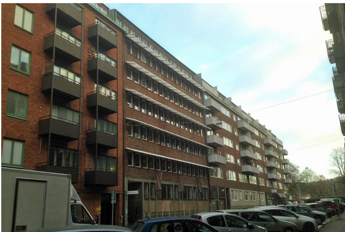
Befintligt utseende mot Baldersgatan (Krook & Tjäder)
