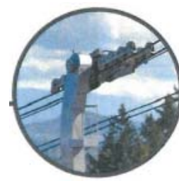
Figur 4 Fast klämma. (Foto från CUP 2013)
