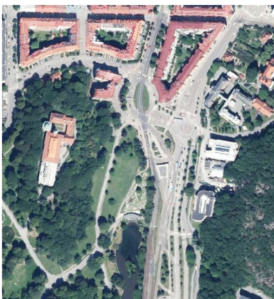
Ortofoto 2022. Trafiken har ungefär samma utbredning som på 1970-talet. Trafikområdet har dock blivit grönare med planterade gröna remsor som separerar de olika kör, cykel och gångbanorna. Bostadsområdet i söder är nu rivet och två större institutionsbyggnader har kommit i stället.
