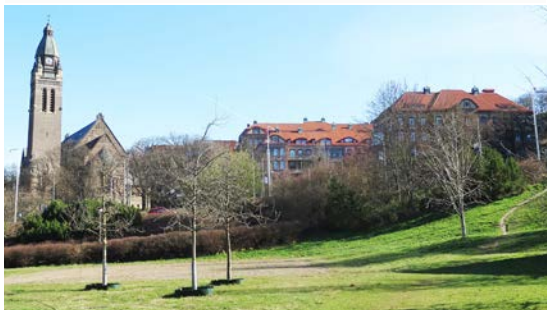
Barnsjukhuset och Annedalskyrkan i förgrunden Karlsrofältet. Notera Barnsjukhusets bakre tillbyggnad.
