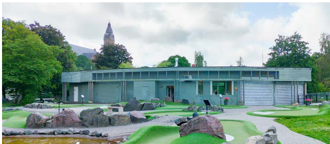
Vid Karlsrodammen intill minigolfbanan är kafébyggnaden uppförd
