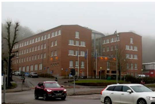
Psykologiska institutionen och dåvarande BASF-huset uppfördes år 1995.
