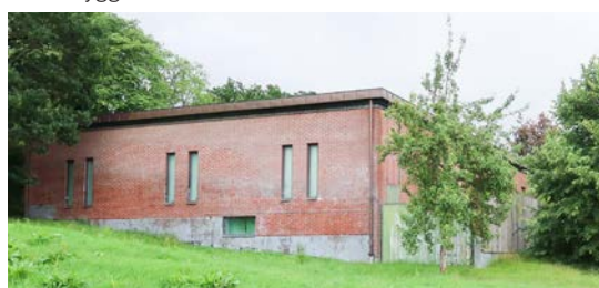
Byggnadens norra fasad som vetter mot den öppna platsen.
