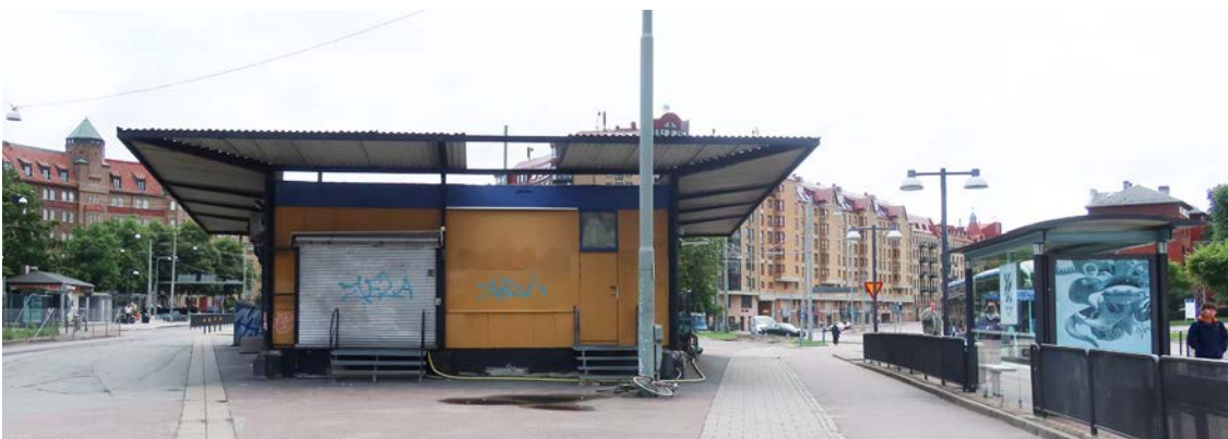
En kiosk är uppförd vid hållplatsen.
