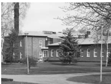
Vackra koppartak på de äldre sjukhusbyggnaderna.
