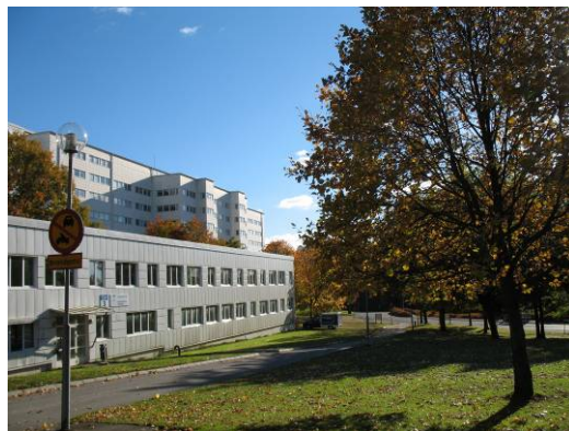
Den lägre byggnaden rivs och ersätts med en park
