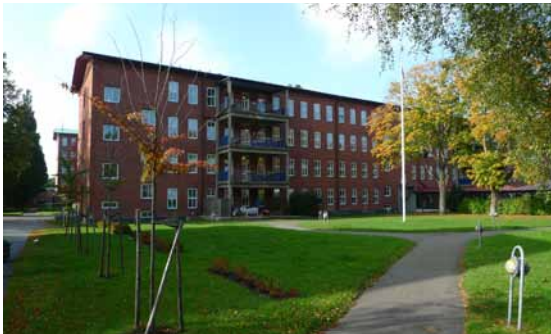
Äldre tegelbebyggelse med moderna tillägg i form av utskjutande balkonger.
