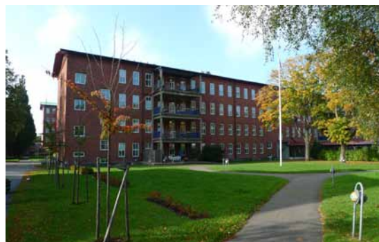
Befintlig vårdbyggnad som skyddas i detaljplanen
