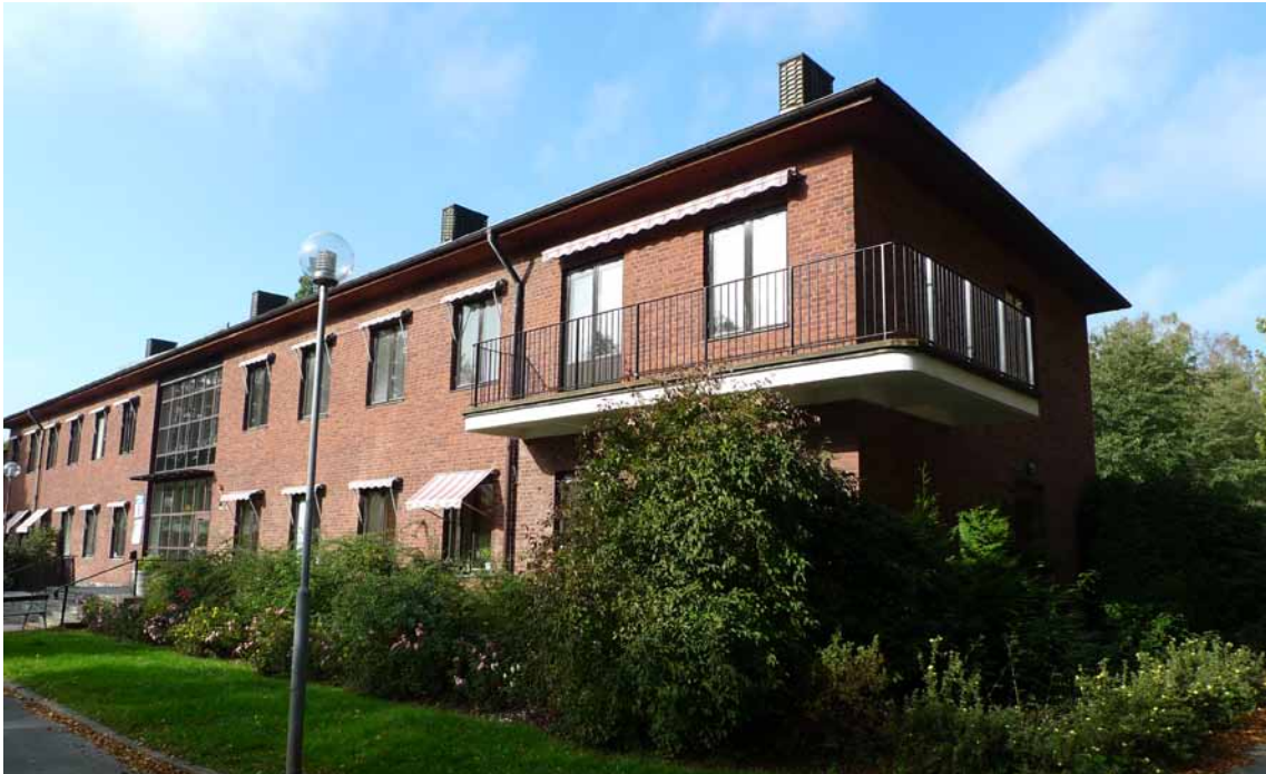
Den gamla administrationsbyggnaden i tegel, med bevarade detaljer som den rundade gavelbalkongen och inglasat entréparti.
