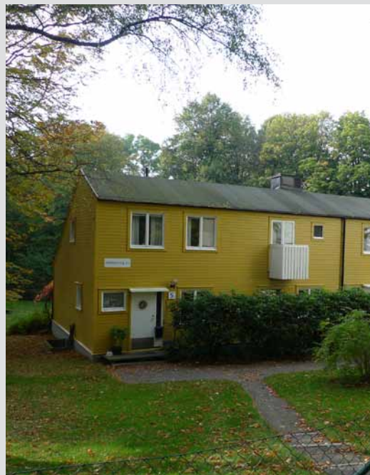
Befintligt radhus är en förebild vid komplettering med nya radhus i delområdet.
