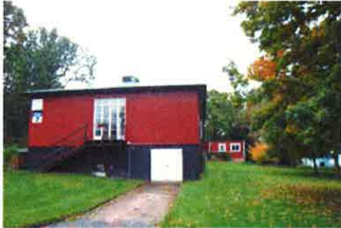
Befintligt hospice som föreslås rivas.
