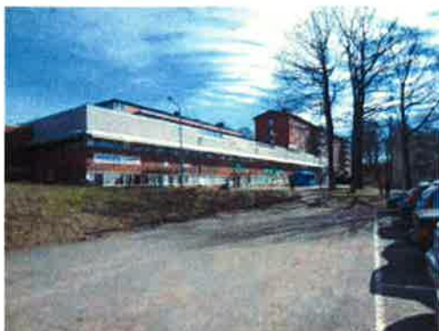
Befintlig byggnad med pizzeria och service-butik
