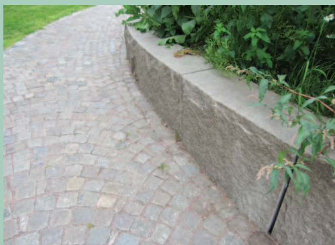
Bra exempel på stödmur i natursten
