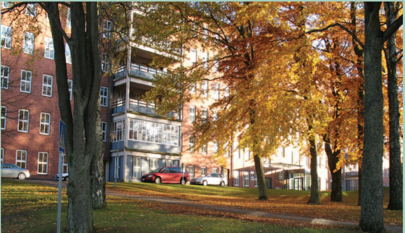
LP 11:s fasad mot området och den sluttande parken
