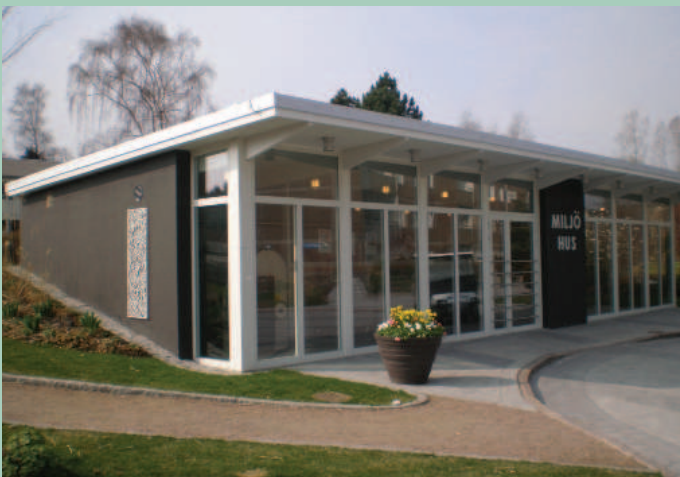
Bra exempel på sopsorteringsbyggnad
