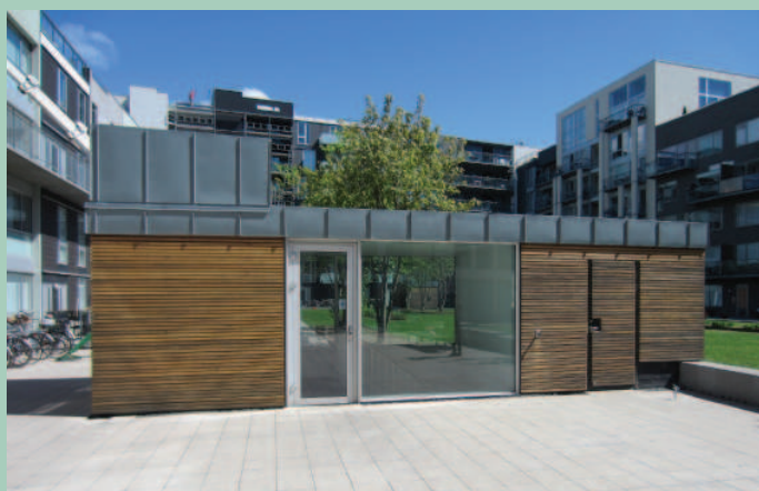
Exempel på entré till underjordiskt parkeringsgarage
