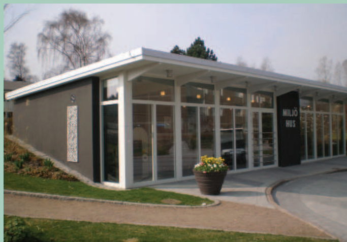
Bra exempel på sopsorteringsbyggnad
