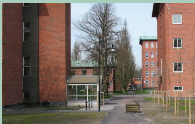
Hisstillägget på LP 8 är exempel på bra tillbyggnad
