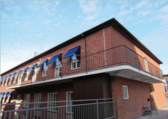
Luftig balkong över hörn
