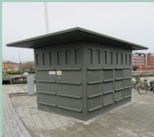
Bra exempel på utformning av teknisk byggnad
