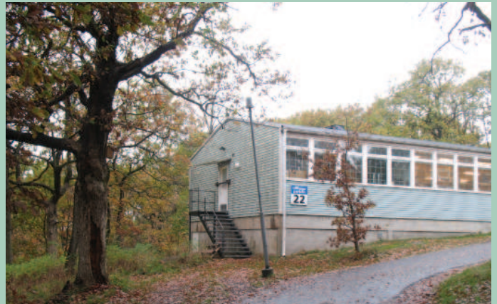
En av verkstadsbyggnaderna
