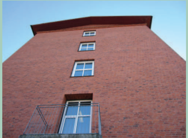
Tegelfris längst upp på gaveln. Här kan man göra om fönstren till balkongdörrar i stil med befintlig balkongdörr och ha balkonger på alla våningar
