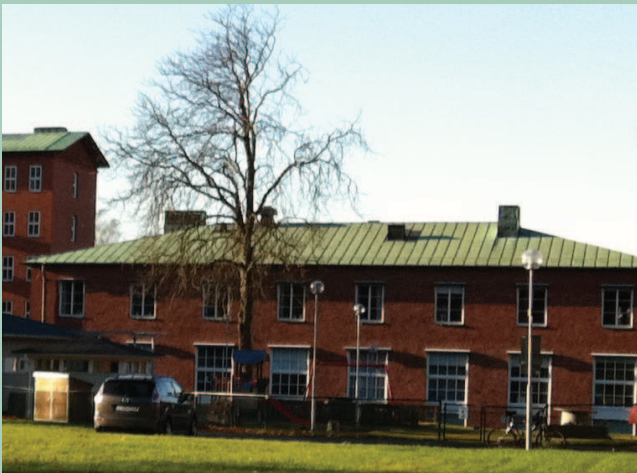
LP 16, förvaltningsbyggnadsom ansluter till område 2
