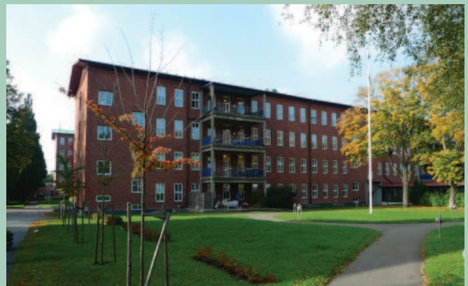
Befintlig vårdbyggnad (LP 10) som skyddas i detaljplanen
