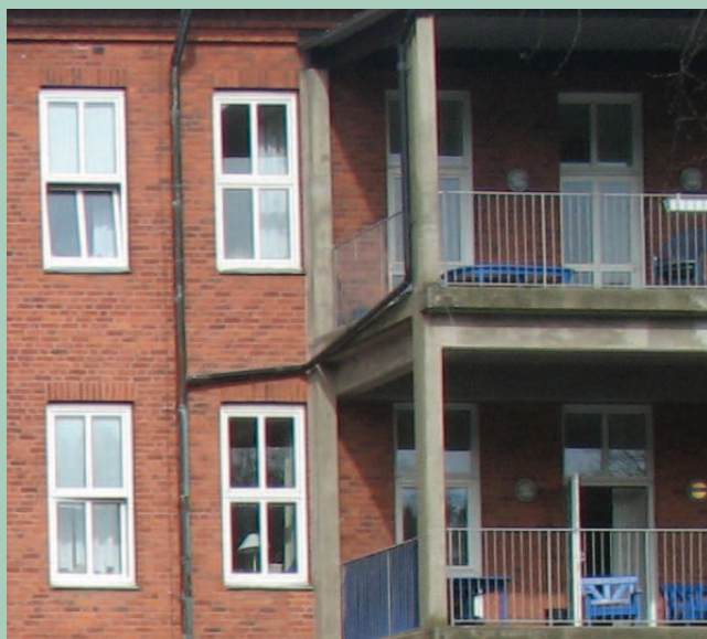
Vid renovering ska till exempel plastfönster bytas mot mer ursprungliga material.
