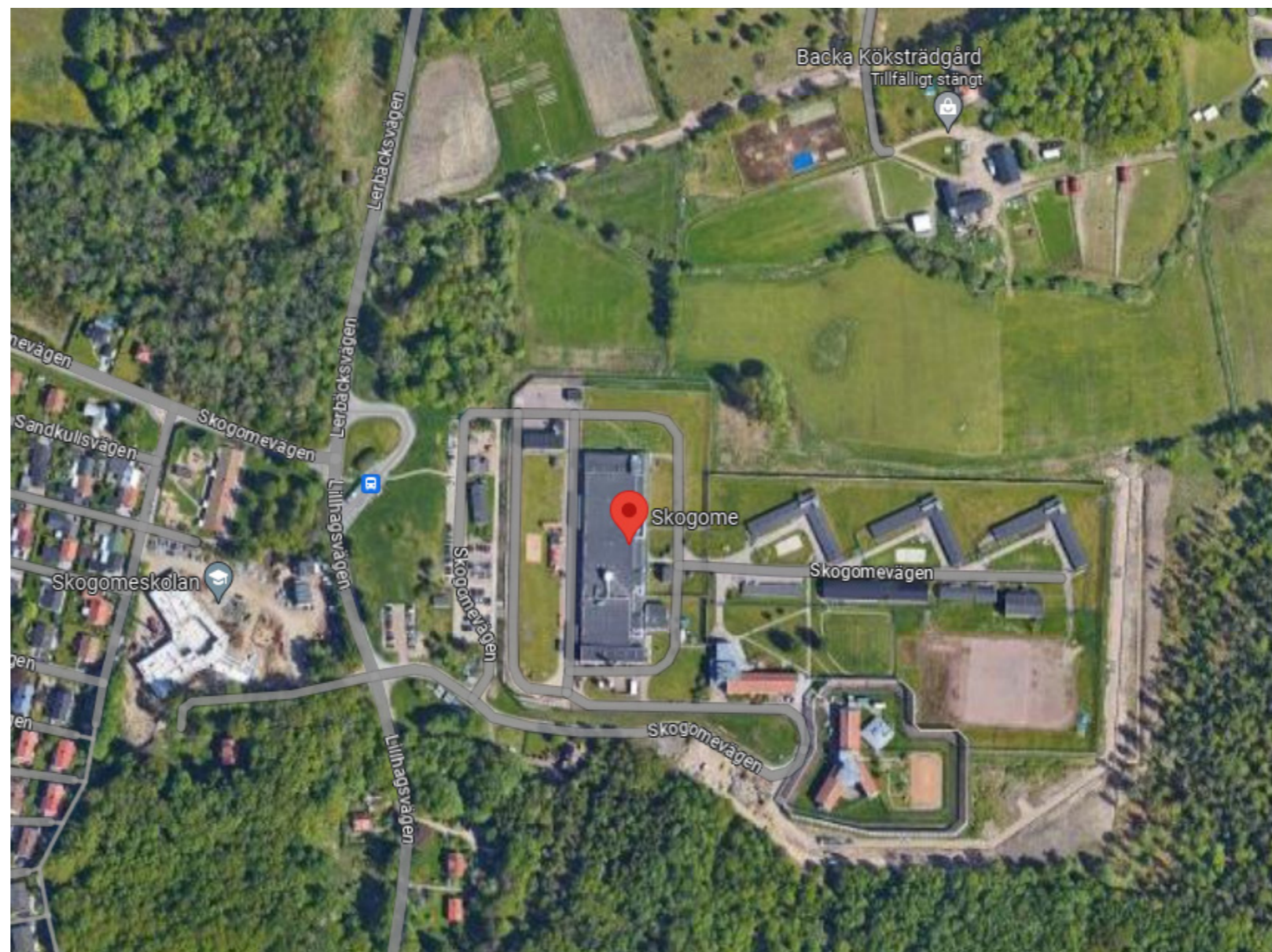
Översikt över Skogomeområdet, anstalt i befintligt utförande. Väster om anstalten syns den nybyggda Skogomeskolan, norr om anstalten syns befintliga villor som efter utbyggnad av anstalten ligger i riskzon för störande belysning. Öster och söder om anstalten syns intilliggande skogsområde.
