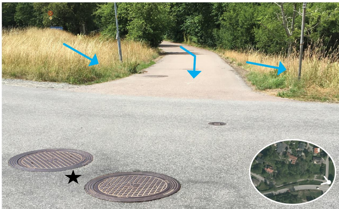
Figur 8. Foto taget i västlig riktning. Gångvägen söder om kvartersmarken lutar fram till en annan anslutningspunkt öster (svart stjärna) om planområdet, i kant med en närliggande fotbollsplan.
