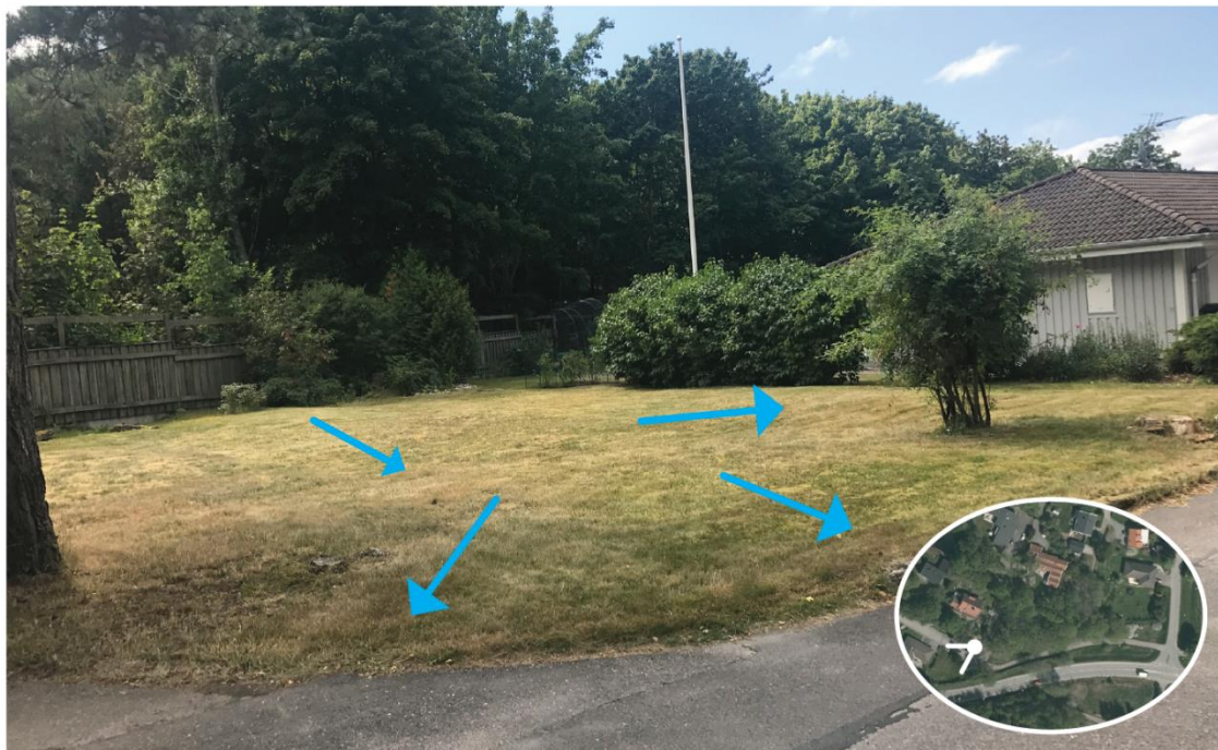
Figur 6. Foto tagen i sydvästlig riktning och visar lutningen på den allmänna platsmarken. Gräsytan lutar mot bilvägen samt mot fasaden på närliggande villa.
