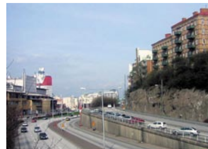
Kvarnbergets nedre del och den halva betongviadukten är en rest av Götaleden.
