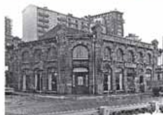
Spännande tegelarkitektur utmed Stora Badhusgatan och ner mot Skeppsbron före rivningarna på 1970-talet.
