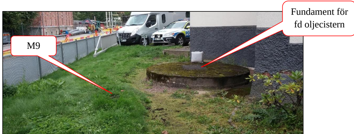
Figur 7. Fundament för fd oljecistern samt M9.
