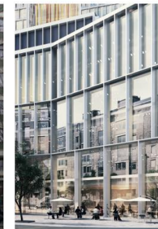
DJUP I FASADEN
