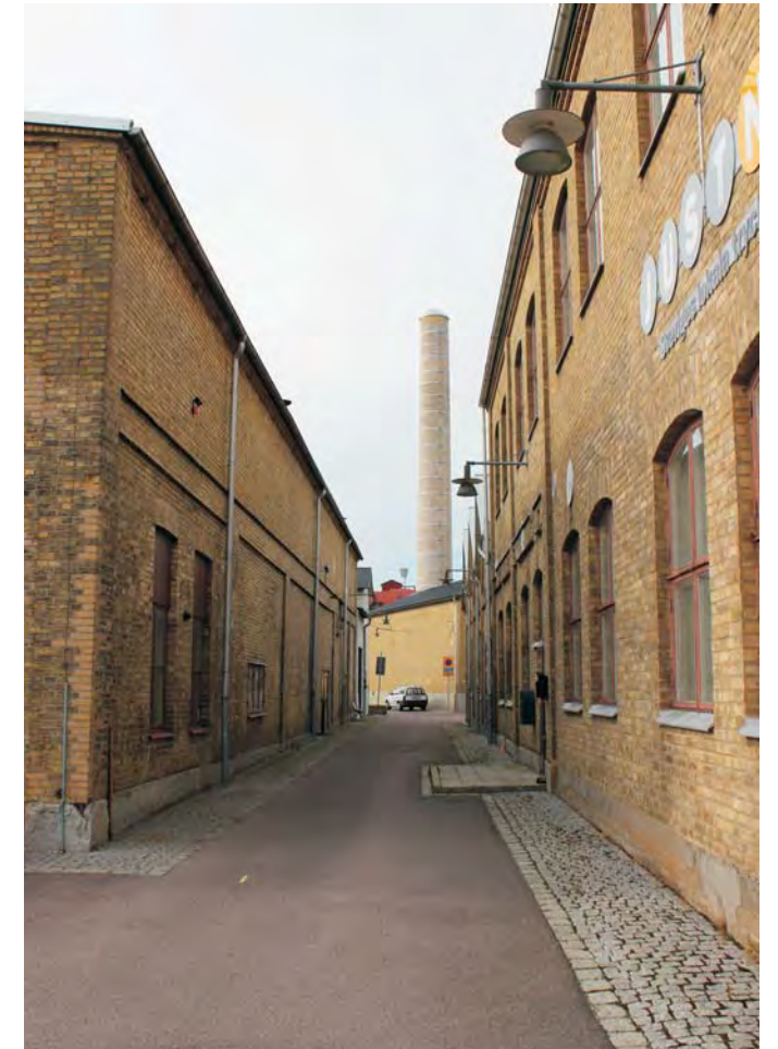
Appreturgränden norrut med skorstenen i siktlinjen.
