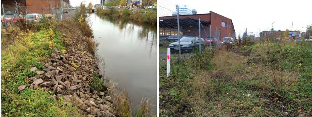
Foto 4 & 5. Erosionsskydd och översvämningvall vid planområdets sydvästra del. Foton tagna åt söder.
