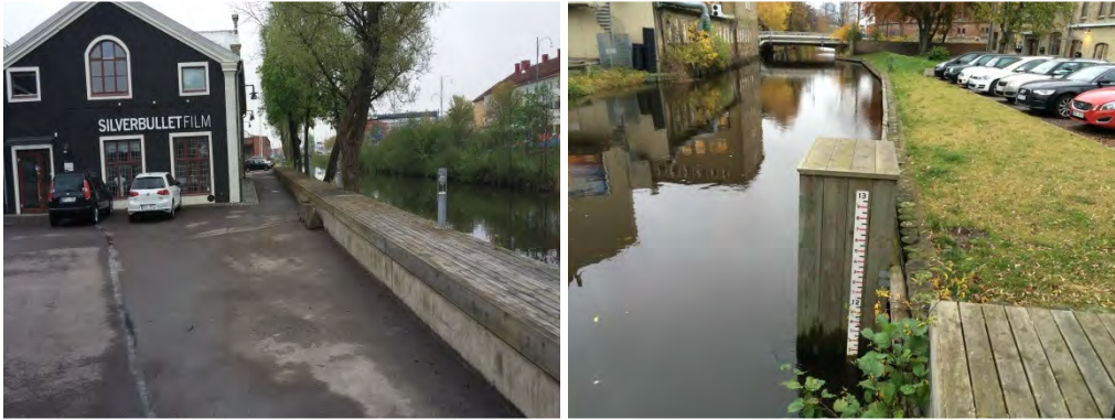
Foto 10 & 11. Befintlig kajkonstruktion av betongelement och kantskoning av tryckimpregnerade träpålar längs Mölndalsån. Foton tagna åt söder (vänstra) och åt norr (högra).
