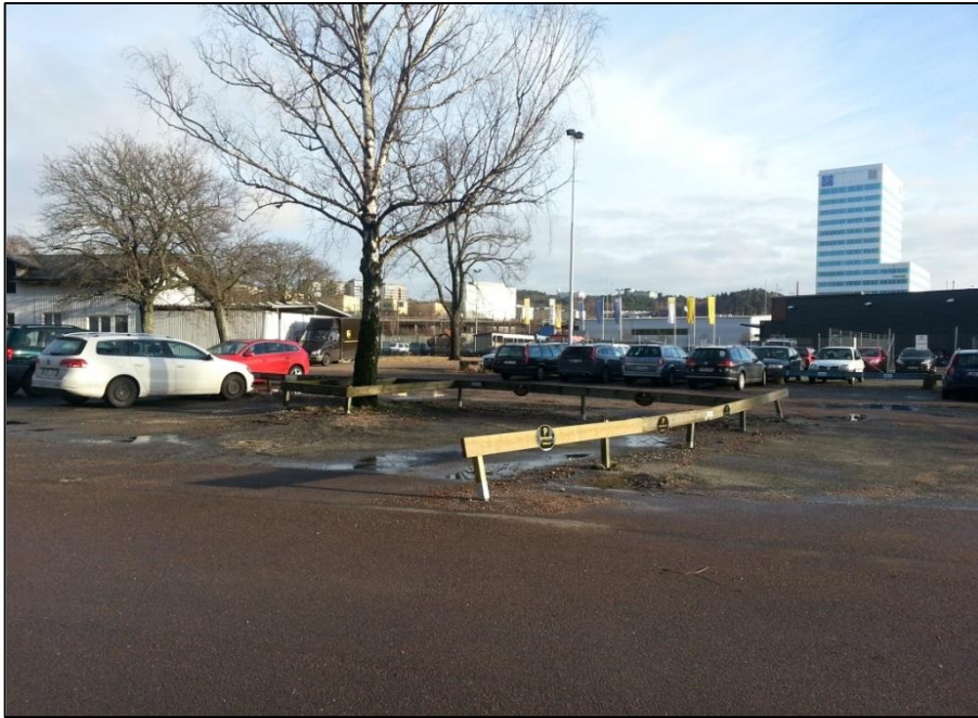
Figur 8. Befintlig hårdgjord parkeringsyta med avvattningsystem genom traditionellt ledningssystem
