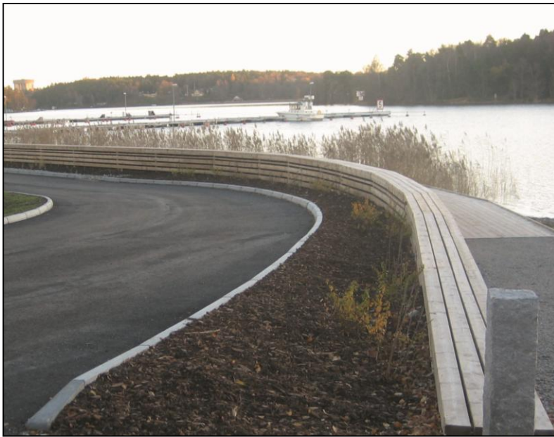
Figur 30. Exempel på utformning av permanent högvattenskydd som ur estetisk synvinkel dolts under en träkonstruktion, Nora strand i Stockholm
