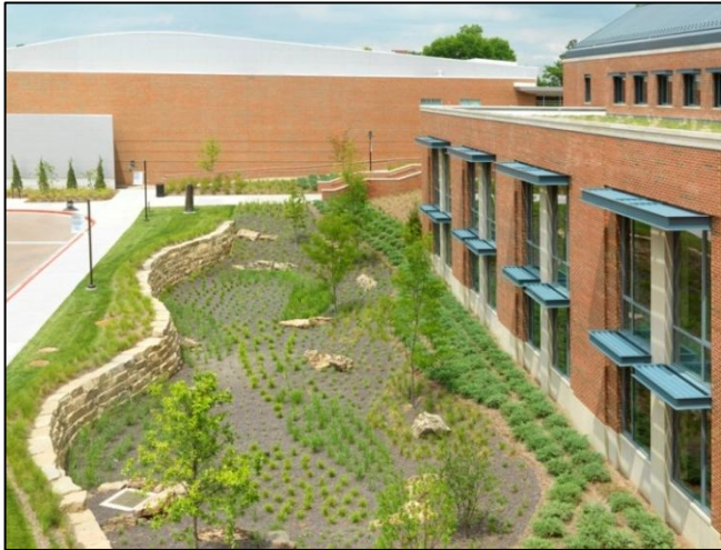
Figur 19. Exempel regnbädd (raingarden) utmed en huskropp
