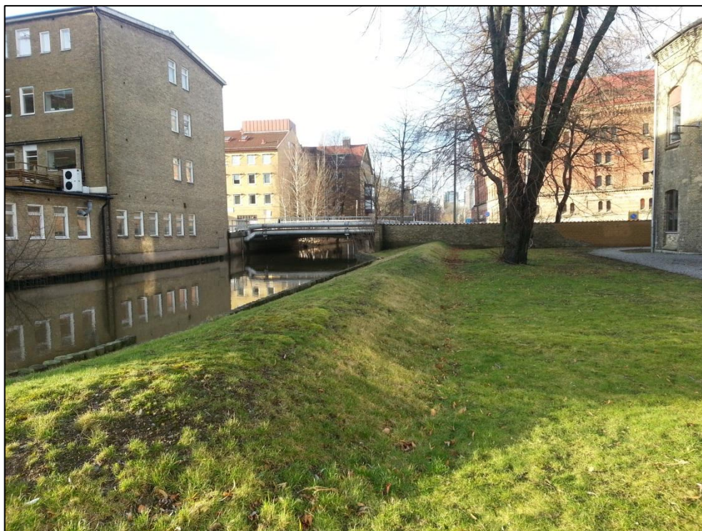
Figur 10. Befintlig skyddsvall i den nordvästra delen av planområdet
