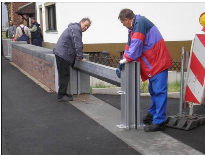
Figur 29. Exempel på utformning av semipermanent högvattenskydd
