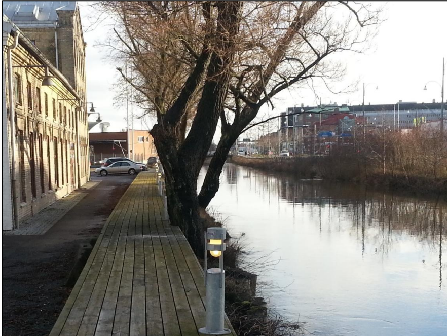
Figur 11. Befintlig skyddsspont i den sydvästra delen av planområdet
