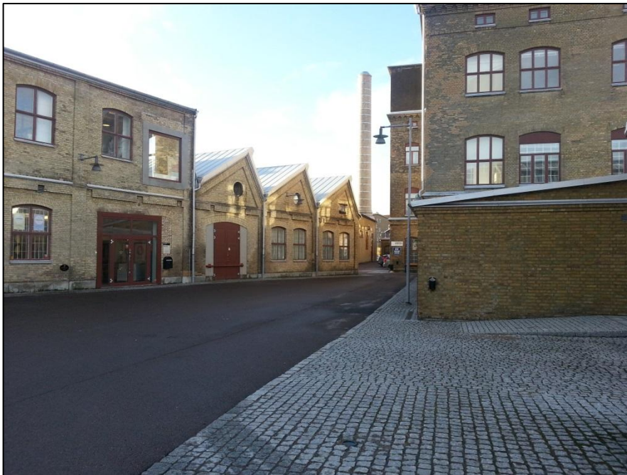
Figur 6. Befintlig dagvattenhantering i området med traditionellt ledningssystem
