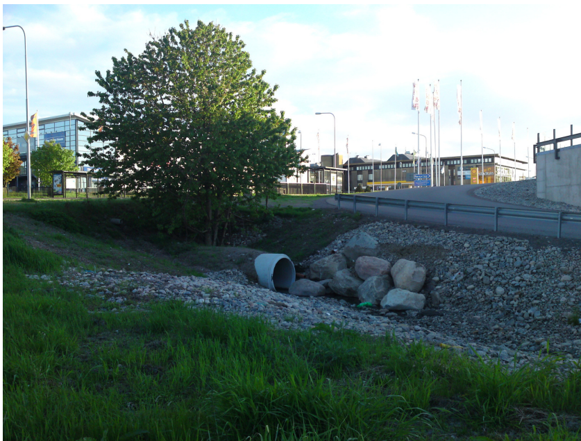
Foto B Dagvattenutlopp, foto 2010-05-23.
