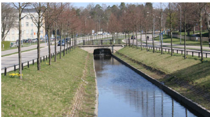
Figur 4 Exempel på kanal för avledning och utjämning, Linnékanalen Växjö.
