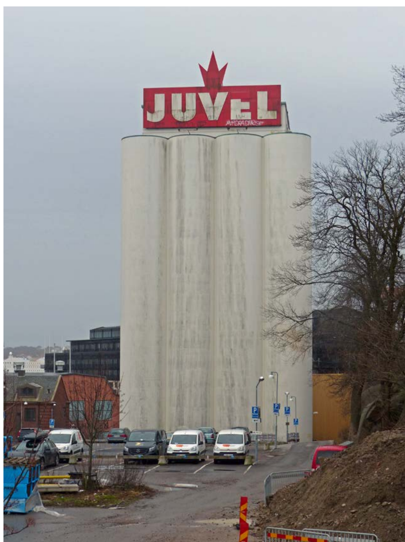
Till höger: Silo 4 i december 2015, från norr. Byggnation pågår i området närmast norr om kvarnen.
