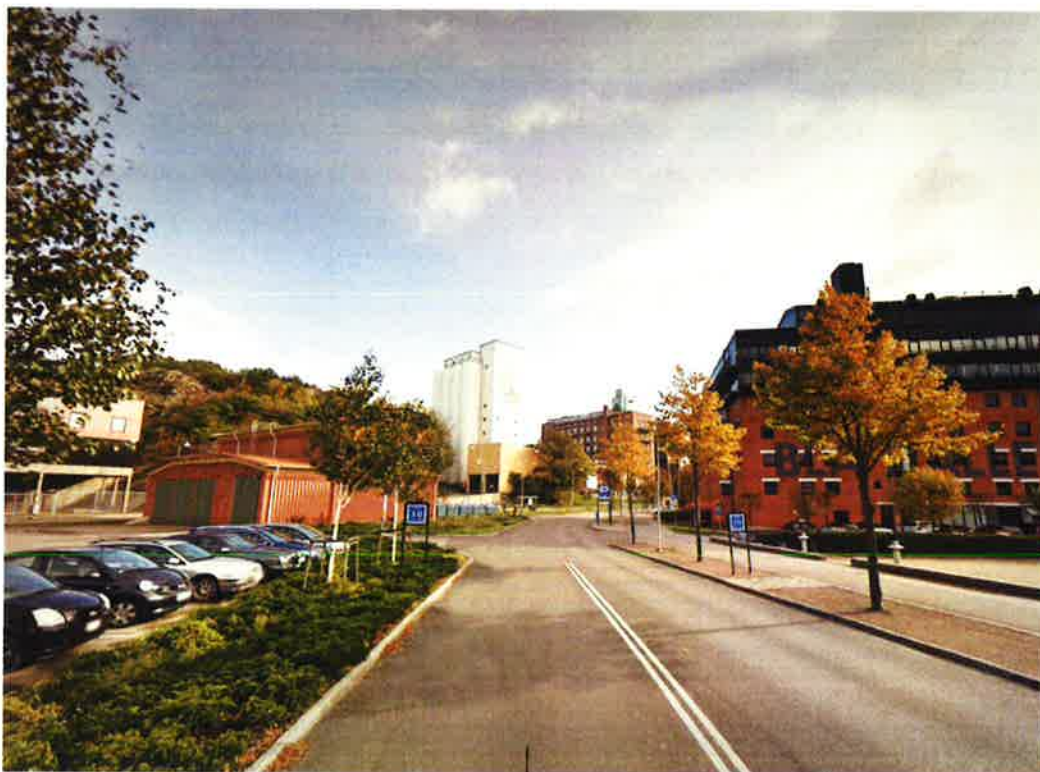
Gatuvy från söder på befintlig silo
