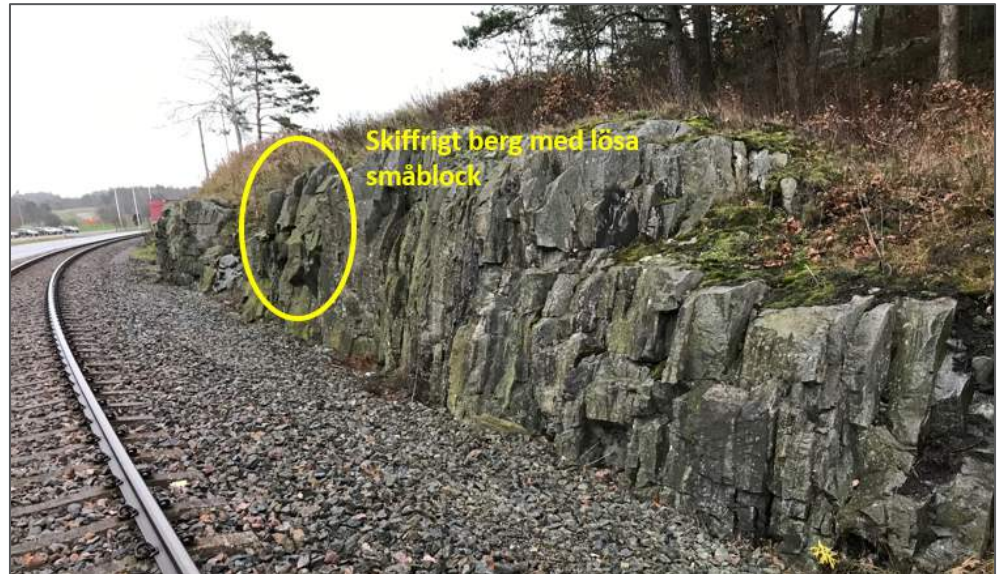
Figur 24. Låg bergskärning med utpräglad skiffrighet. Det breda diket fångar upp blocknedfall och gör åtgärder onödiga.
