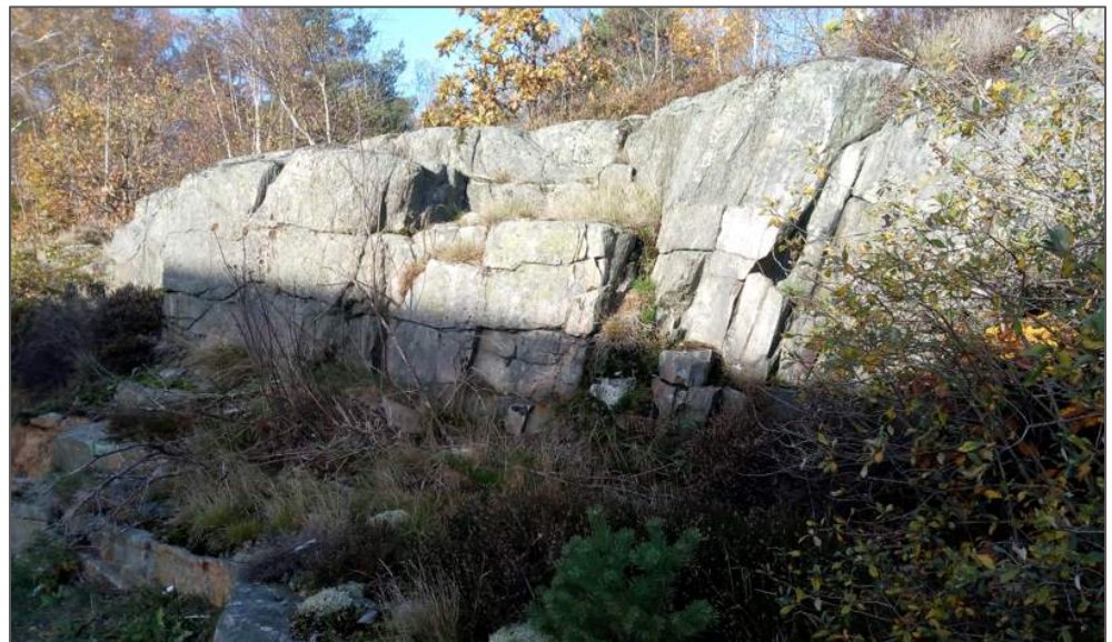
Figur 33. Mycket uppsprucken, men stabil, skärning. Släntstabiliteten bör ses över vid byggnation eller vibrationsalstrande arbeten intill slänten.
