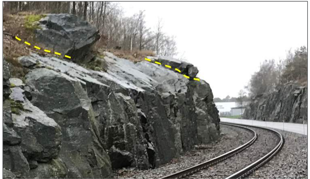
Figur 28. Ogynnsamma planstrukturer visas med streckad linje. Skärningskrönen bör anpassas till sådana strukturer genom att ytan ovan dem rensas på lösa block.
