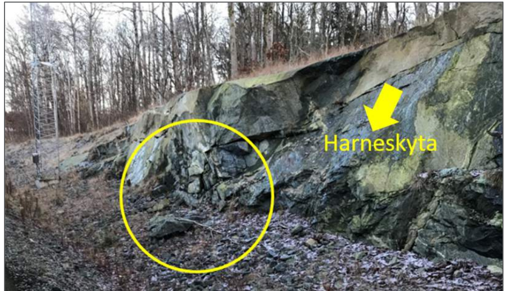
Figur 32. Utrasat material inringat. Den kloritbeklädda harneskytan utgör en glidyta.
