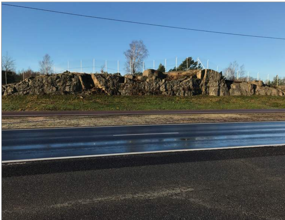
Figur 15. Bergskärning i anslutning till motorvägstestbanans västra gräns.
