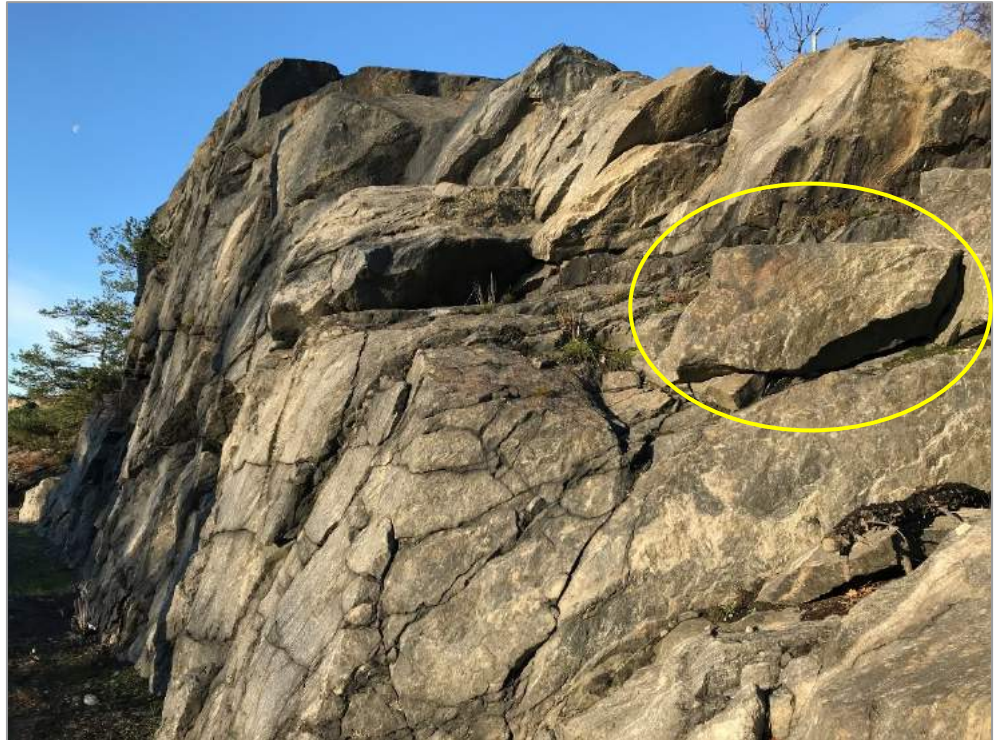
Figur 17. Kraftig uppsprickning. Löst block (inringat) synligt till höger i bild.
