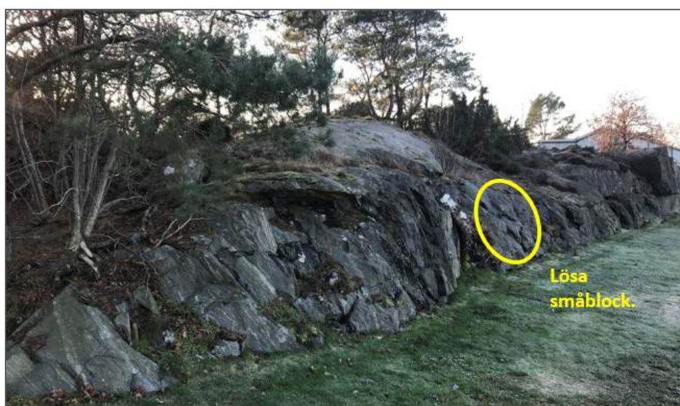
Figur 35. Skärning söder om motorvägtestbanan. Skärningen är stabil men lokalt förekommer lösa småblock.
