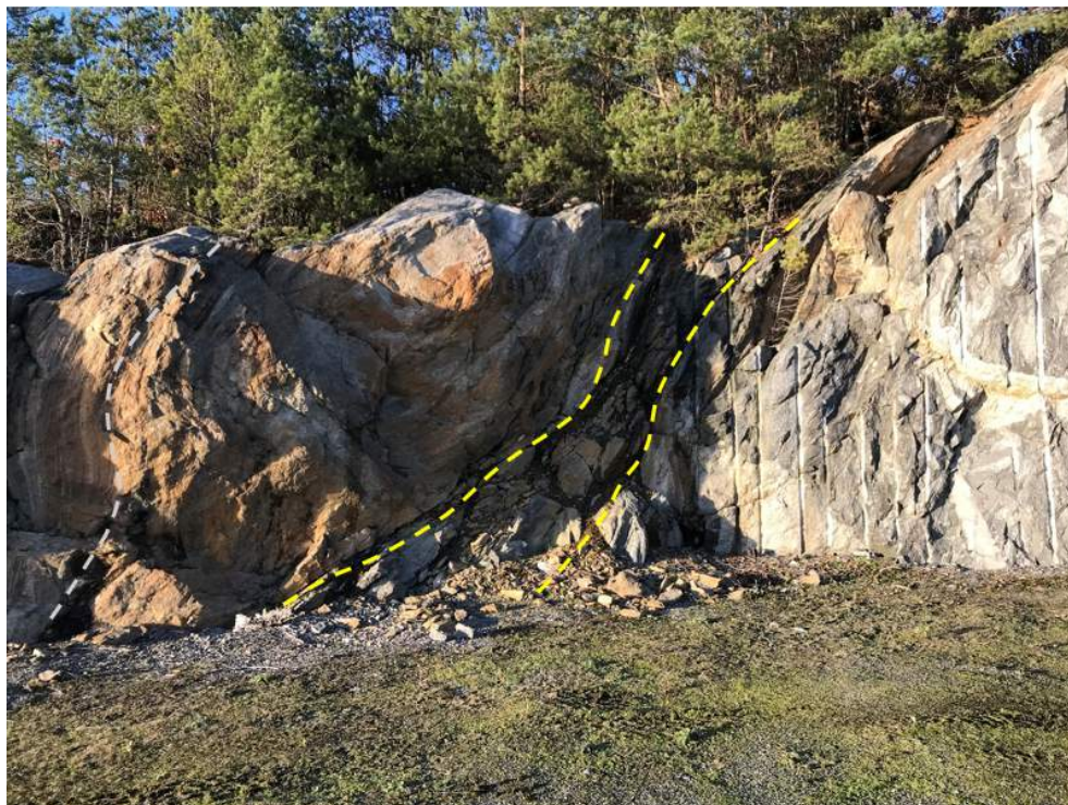
Figur 5. Skärning i anslutning till krocktestanläggningen som uppvisar tydlig veckning (grå streckad linje). Synlig i mitten av bilden är också en skiffrig svaghetszon (gula streckade linjer).
