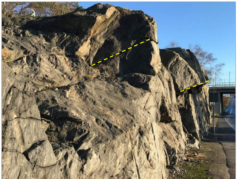
Figur 18. Skärning längs Fördelarvägen, foto taget från öster mot TX-porten. De flacka sprickplanen lutar mestadels in i skärningen, se streckad linje för exempel.
