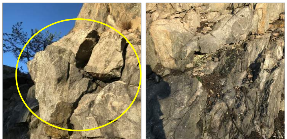
Figur 37. Lösa block inringat till vänster, till höger exempel på kraftigt uppsprucket berg.
