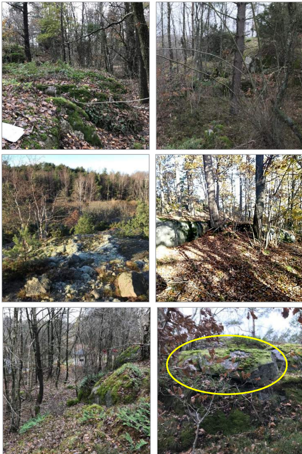
Figur 12. Exempel på typiska naturliga bergslänter i området. Gul ring visar ett exempel på ett löst block i form av en skiva som riskerar att glida ut.
