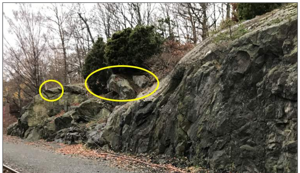
Figur 29. Inringade områden bör bli föremål för skrotning så att släntöverytan anpassas efter naturliga strukturer.
