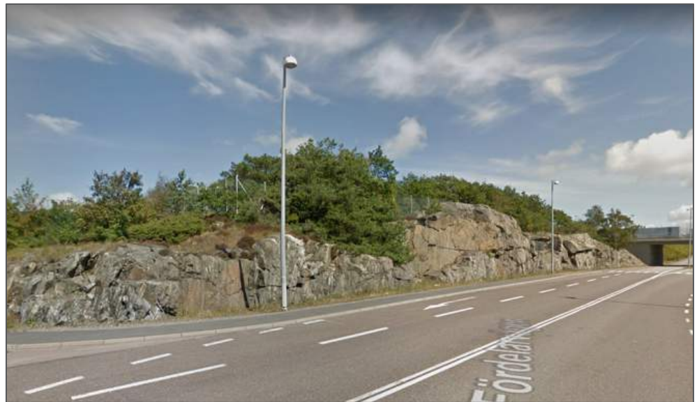
Figur 36. Skärning ett kort stycke väster om TX-porten. Skärningen är mycket sprängskadad och har en del lösa block. © Google.
