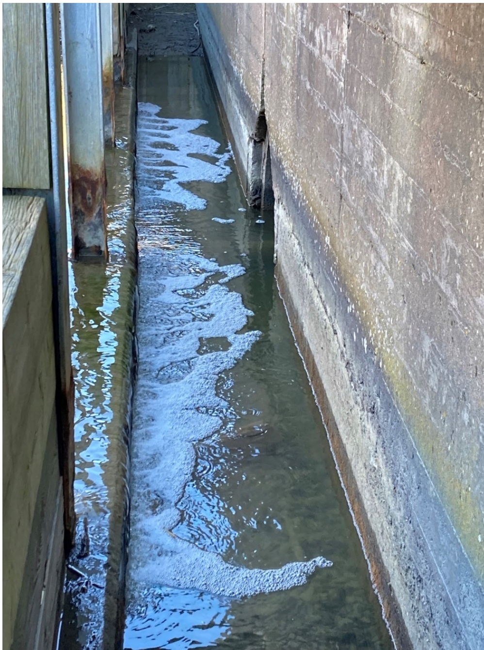
Figur 7. Vattennivåskillnad vid skibord mellan Karholmsdammen och Södskärsbassängen, foto taget från Karholmsdammens sida.
