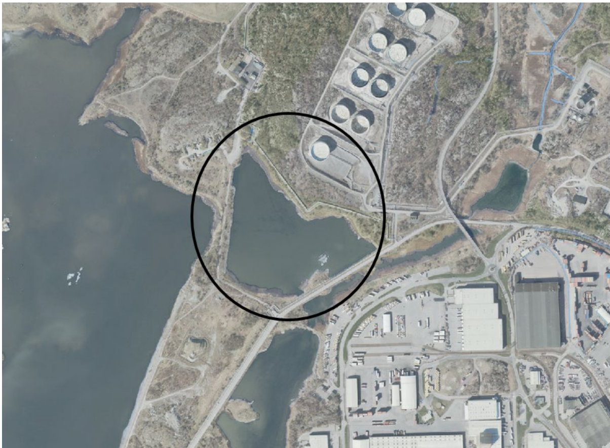
Figur 17. Befintlig dagvattentunnel mynnar i Södkärsbassängen (markerad med svart cirkel) som är en del av Torsvikens Natura 2000 område.
