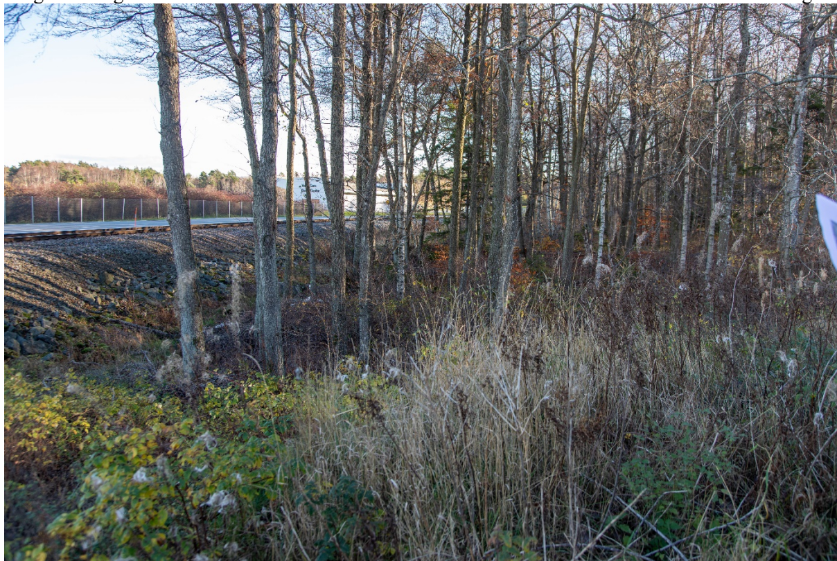
Figur 3 Lågpunkt och dike, söder om järnvägsspåret i delområde A:s norra del.
