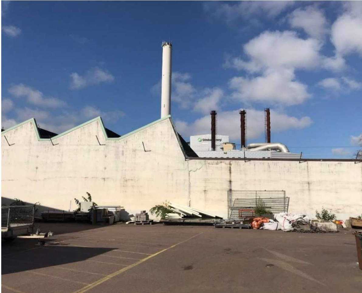
Befintlig industribyggnad med sitt karaktäristiska sågtandstak (Foto: Stadsbyggnadsförvaltningen)
