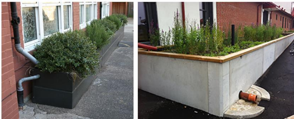
Figur 12. Biofilter i upphöjd planteringslåda. (Bildkälla: rent-dagvatten.se)
