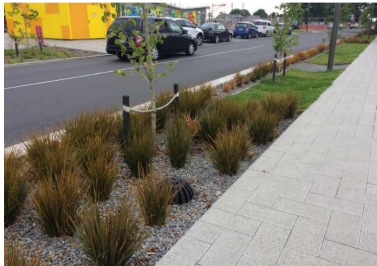
Figur 8. Exempel på makadamdike som täckts med växter och gräs.
