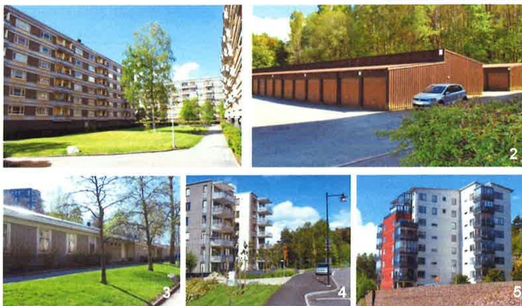
Bilder: Befintlig bebyggelse inom och i närheten av planområdet: 1.lamellhusen, 2. garagelängor, 3.förskola, 4.flerbostadshus vid Träkilsgatan, 5.flerbostadshus vid Östra Torpavägen.
