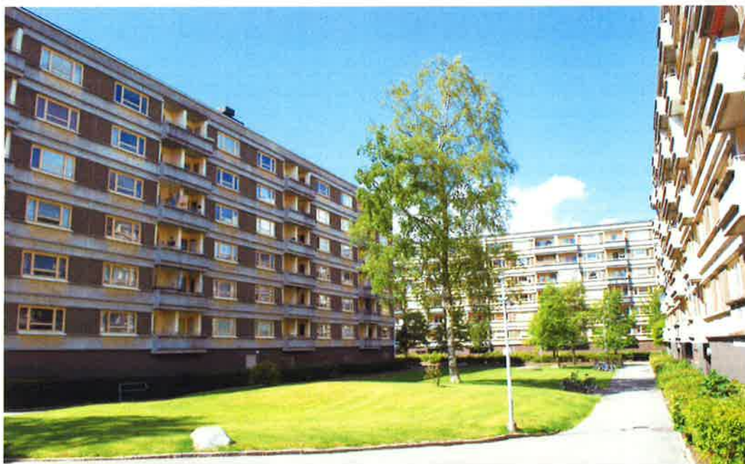
Bild: Befintliga flerbostadshus vid Smörslottsgatan/Östra Torpavägen.
