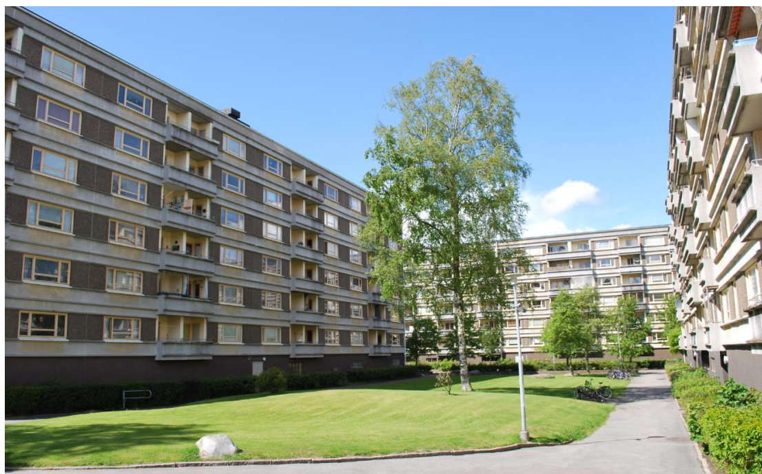
Bild: Befintliga flerbostadshus vid Smörslottsgatan/Östra Torpavägen.
