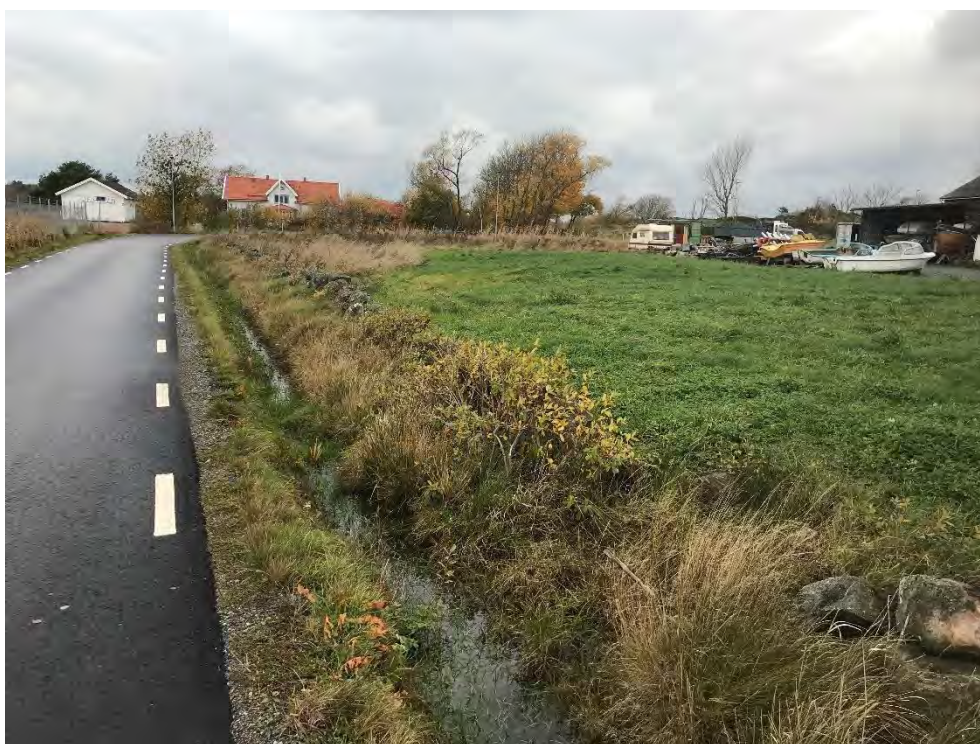
Figur 60. Stenmuren fotograferad västerut.
