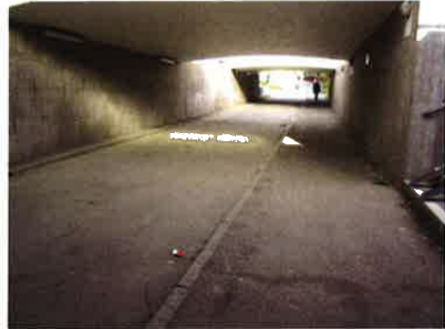
Gång- och cykeltunneln under Hjalmar Brantingsgatan och spårvagnsspåren.
