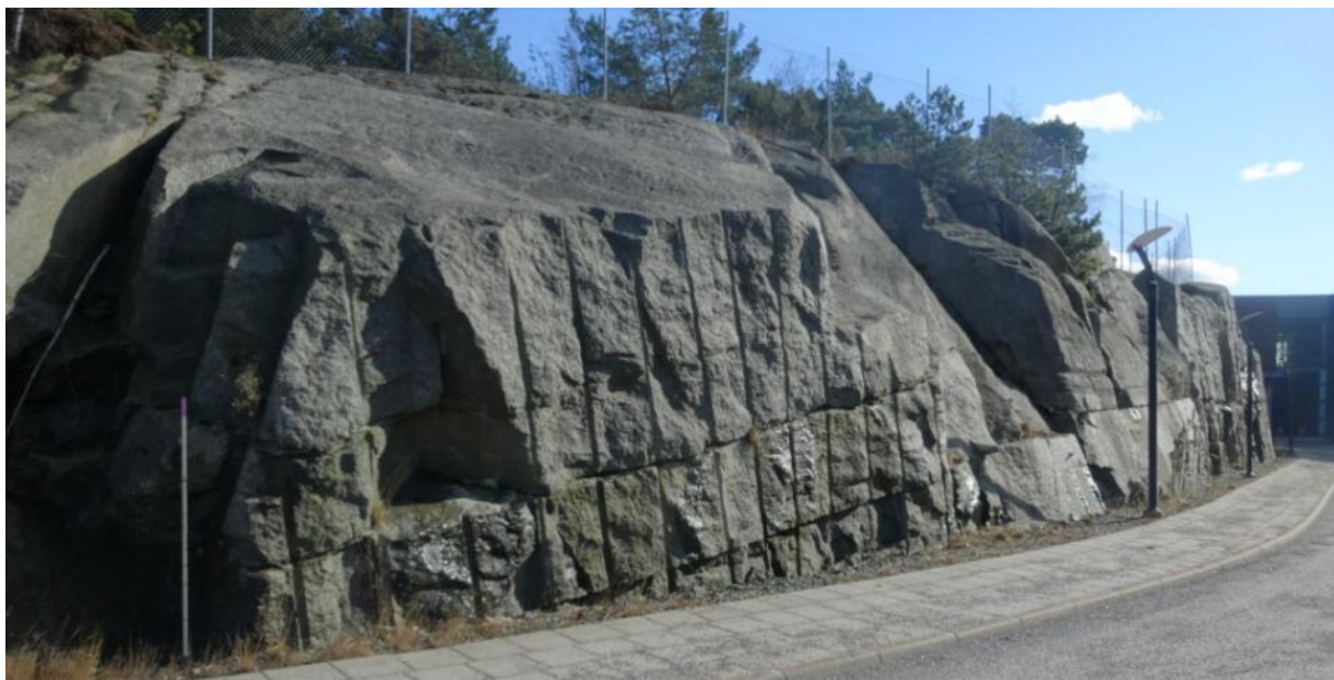
Bild 13 tagen mot sydost där mas ser massivt berg som även har täckts av upptill staketet där uppe.
