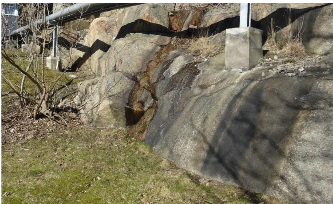
Bild 6 på berghällar närmare stödmuren. Generellt är berget massivt med få sprickor. Mörkare områden är där ytligt vatten rinner efter regn.
