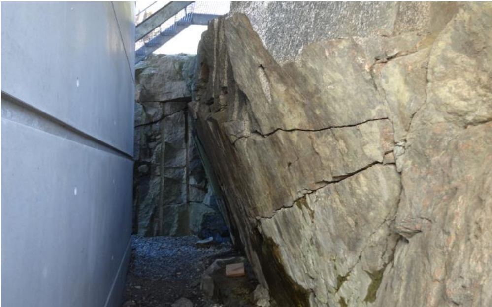
Bild 7 tagen mot öster längs med södra fasaden där utrymme skapats för att få dit byggnaden. Inga stabilitetsproblem kunde konstateras.
