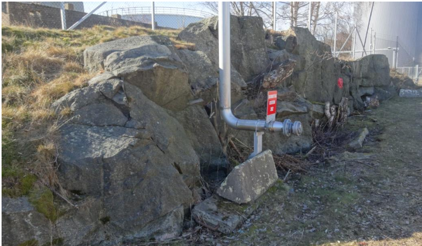
Bild 28 tagen mot nordväst där man ser att mindre sprängning har utförts.
