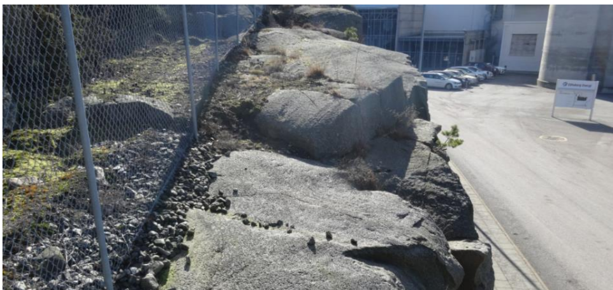
Bild 15 tagen mot söder där man ser övergången mellan begränsade jordlager på berg utanför staketet till vänster och avtäckt berg till höger inom området.
