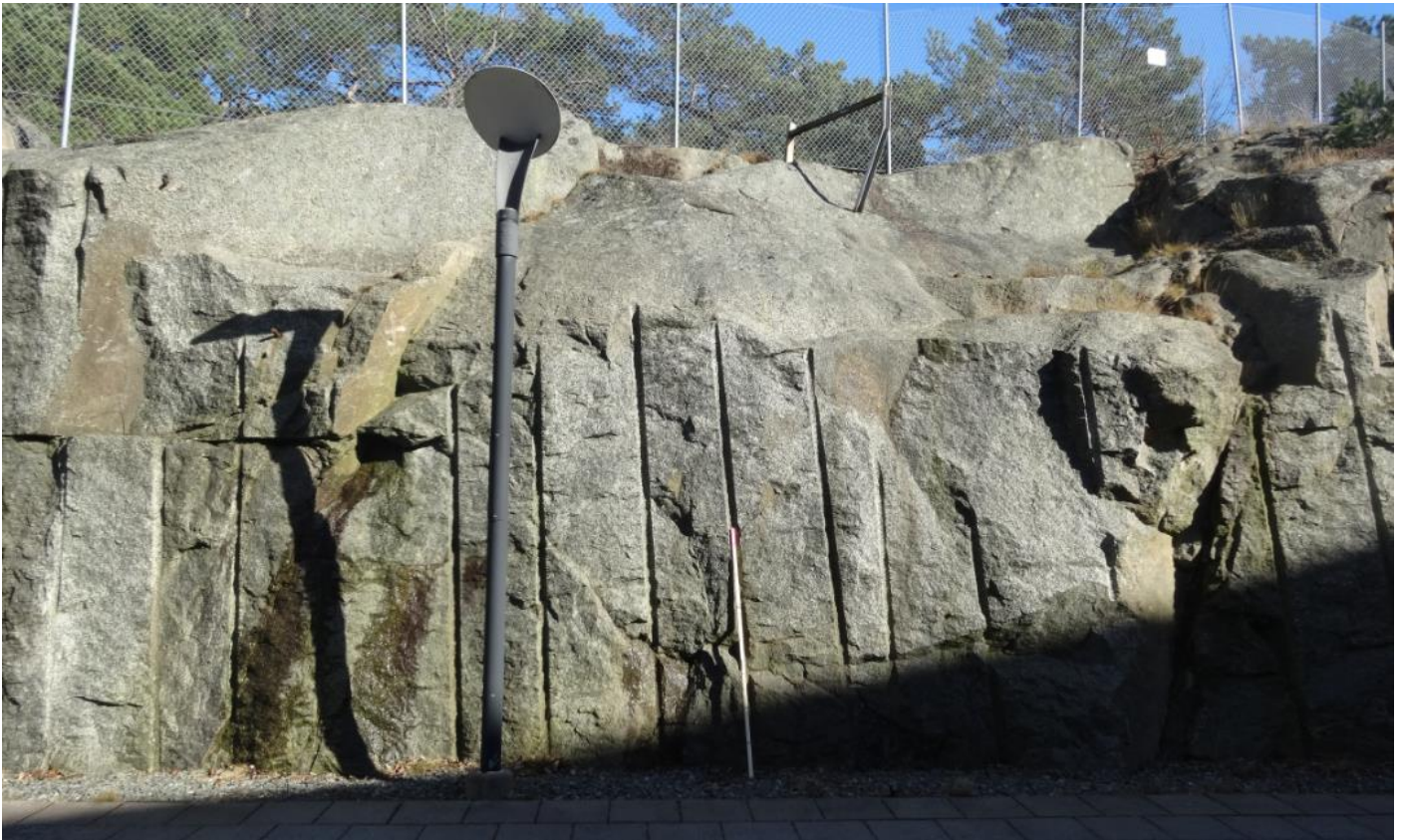
Bild 11 mot öster på berget där skärningen är upptill 5 m inklusive ej sprängt berg. Generellt är berget av god kvalitet utan några sprickzoner.
