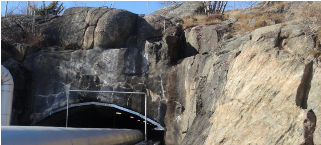
Bild 23 tagen på tunnelpåslag för ledningar. Ett speciellt block finns övre högra hörnet där sprutbetong påförts. Markering har gjorts på planskissen (4:1 block).
