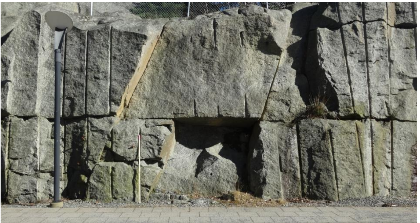
Bild 12 längre norrut där man ser att ett lokalt överhäng har skapats i mitten där nere, men inga stabilitetsproblem föreligger. Endast få sprickor finns det är vertikala rester från borrhålen vid sprängningen som syns vertikalt.
