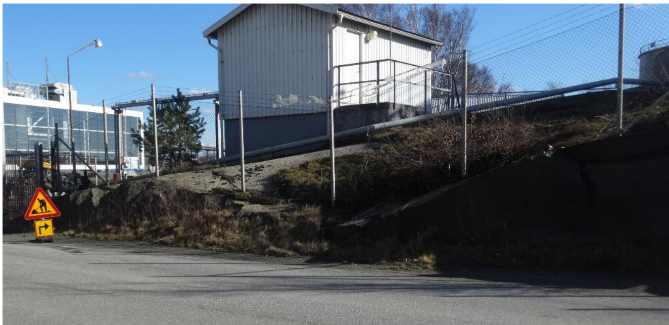
Bild 31 tagen mot söder på den östra delen närmast Nabbevägen. På gränsen till lokal jordslänt finns.
