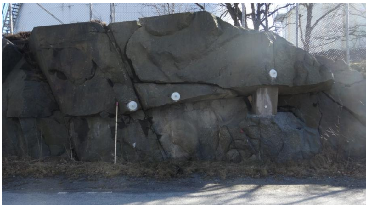
Bild 33 tagen mot söder där man gjutit en kub och bultat för att säkerställa överhänget. Området ligger strax utanför detaljplanområdet.
