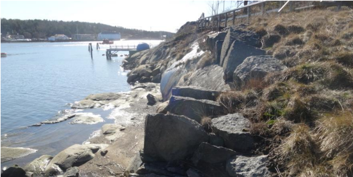
Bild 22 tagen på remsa mellan gångstråket och vattnet. Mycket stora block har lagts ut men några stabilitetsproblem bedöms ej förekomma.
