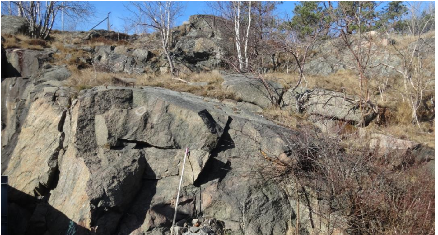
Bild 20 tagen mot norr där man ser att endast 2 m bergskärning har skapats.
