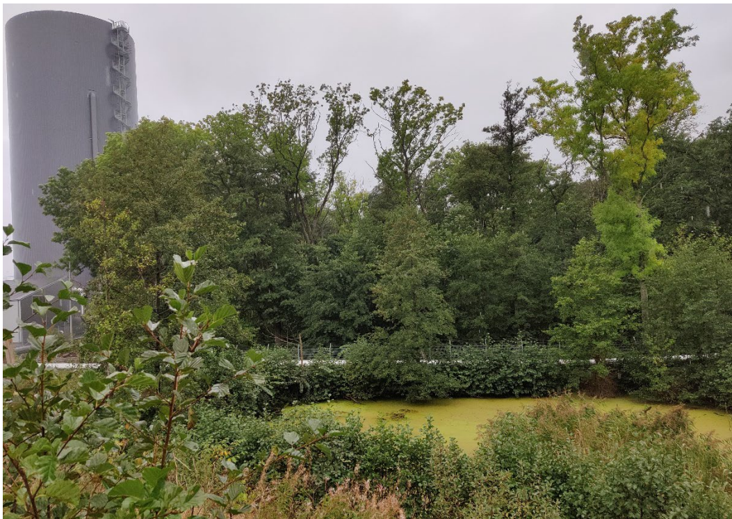
Fotografi över den stora dammen, med den nybyggda ackumulatortanken i bakgrunden.
