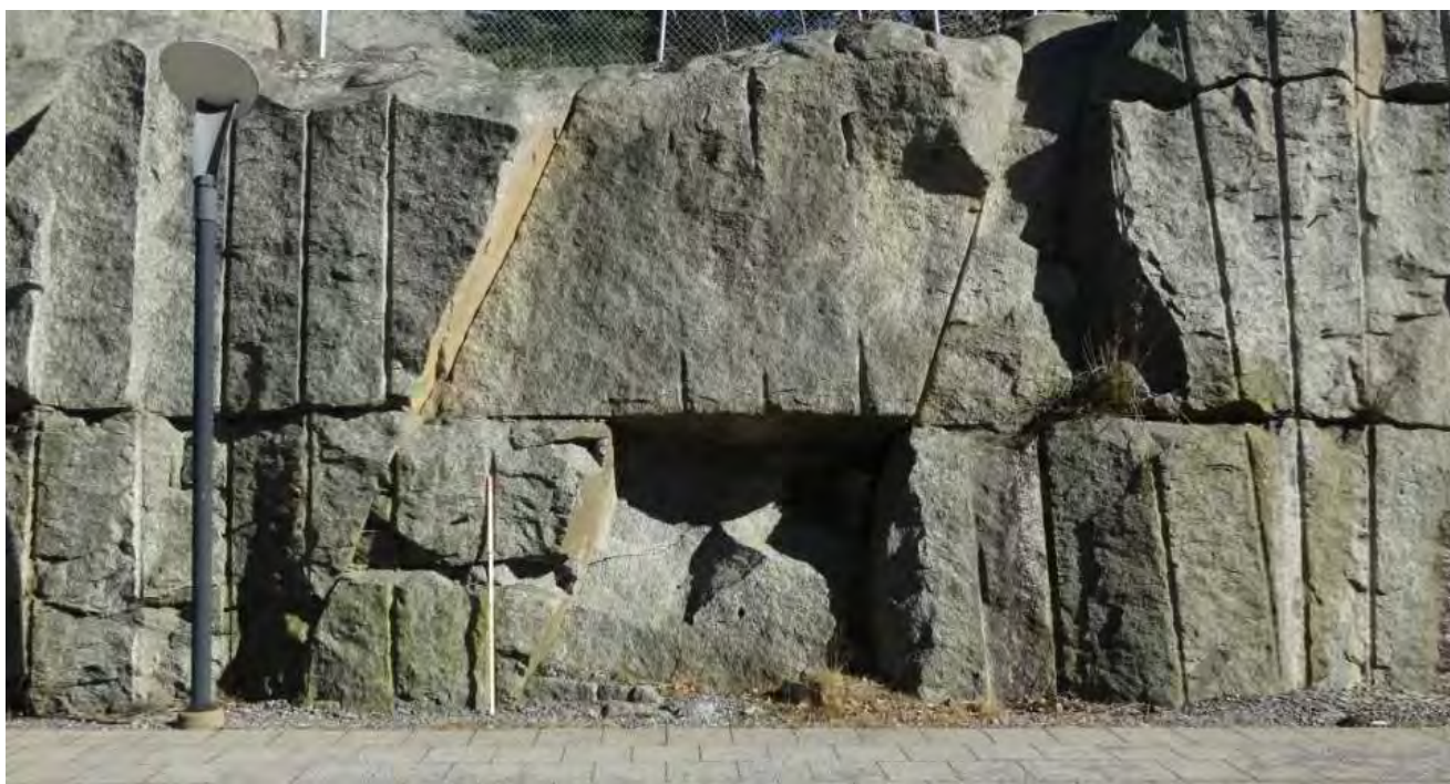
Bild 12 längre norrut där man ser att ett lokalt överhäng har skapats i mitten där nere, men inga stabilitetsproblem föreligger. Endast få sprickor finns det är vertikala rester från borrhålen vid sprängningen som syns vertikalt.
