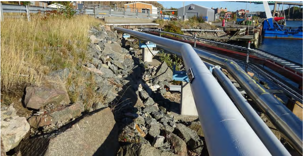
Bild 9 på området närmast intill vägräcket vid böjen på ledningarna där finns den del massor som har lite brantare lutning.
