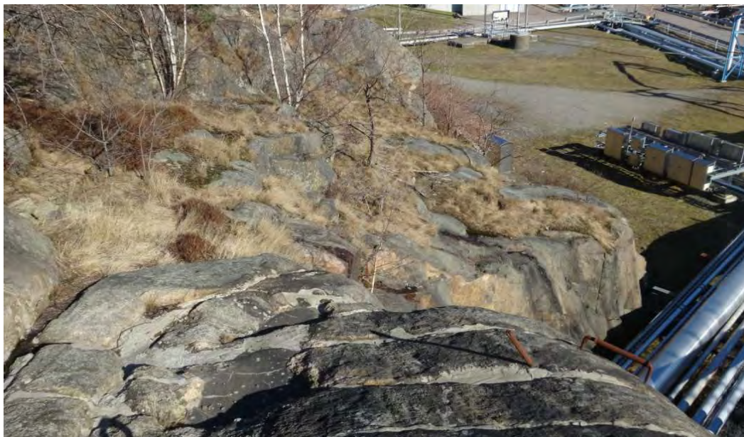
Bild 25 på avtäckt flackt berg ovan tunneln. Ljusare stråk är sprickor som fyllt med sprutbetong för att tätat tunneln.
