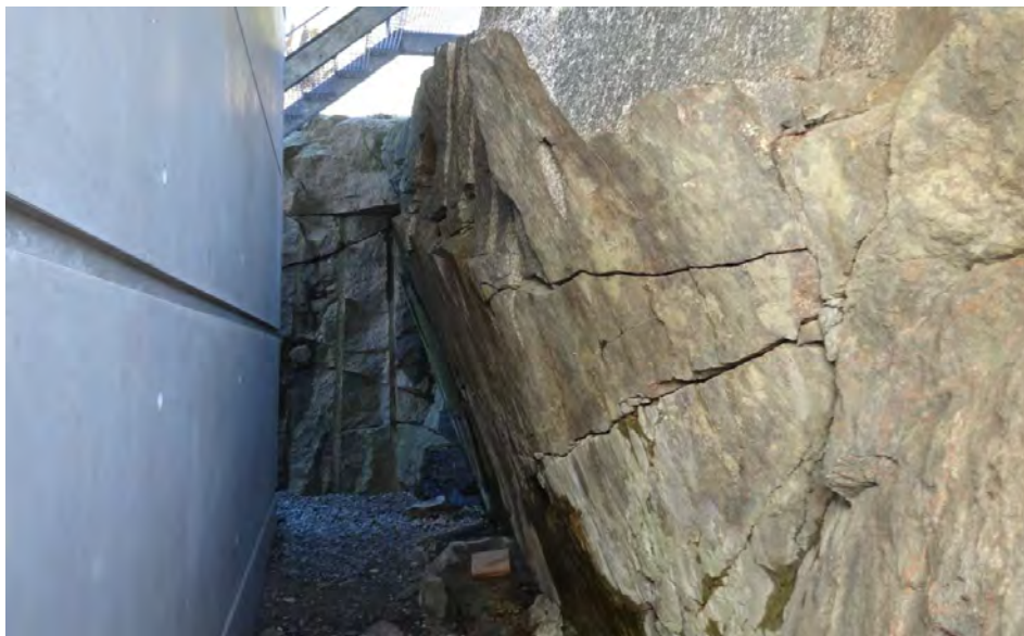
Bild 7 tagen mot öster längs med södra fasaden där utrymme skapats för att få dit byggnaden. Inga stabilitetsproblem kunde konstateras.
