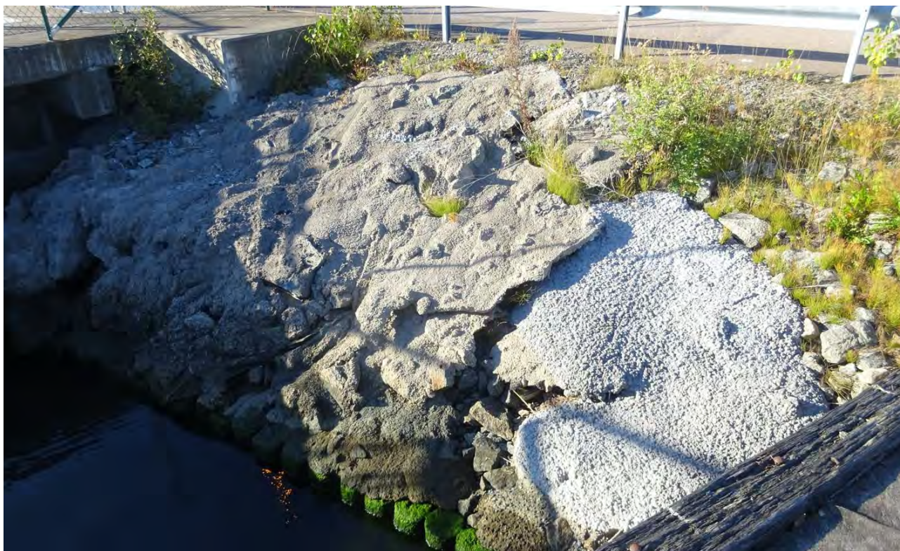
Bild 4 tagen från träbryggan på området längst i väster där man ser gröna tröpålar och grovbetongen som låser fast krossmaterialet. Lutningen är flack.
