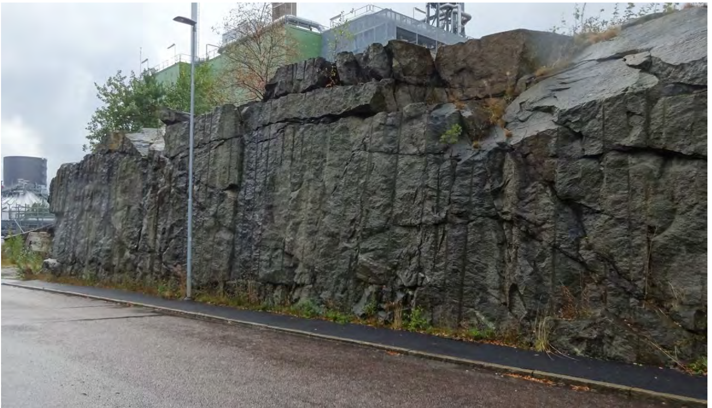
Bild 22 på sydligare delen med även gjutna konstruktioner högst upp.
