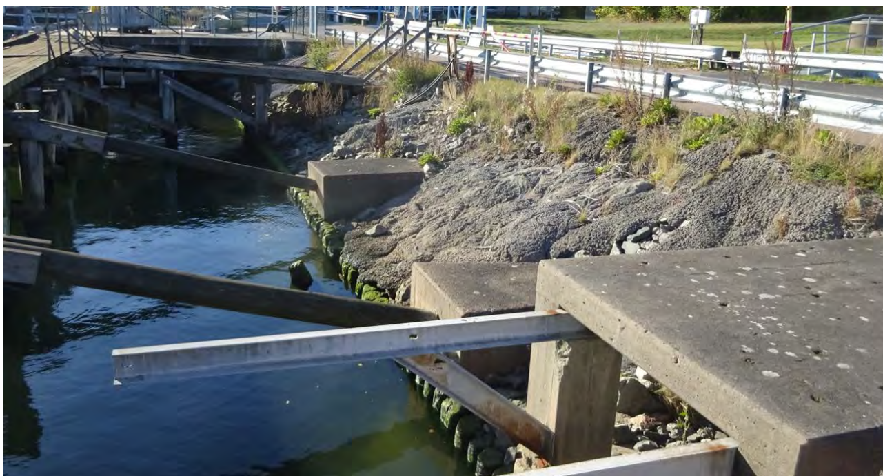
Bild 3 tagen mot väster på området där träpålar finns vid kanten mellan vatten och erosionsskyddet. Erosionsskyddet består av grövre krossmaterial som till stora delar har påförts grovbetong. Lutningen är måttlig (1:1.5 - 1:2) och stabiliteten bedöms vara god.
