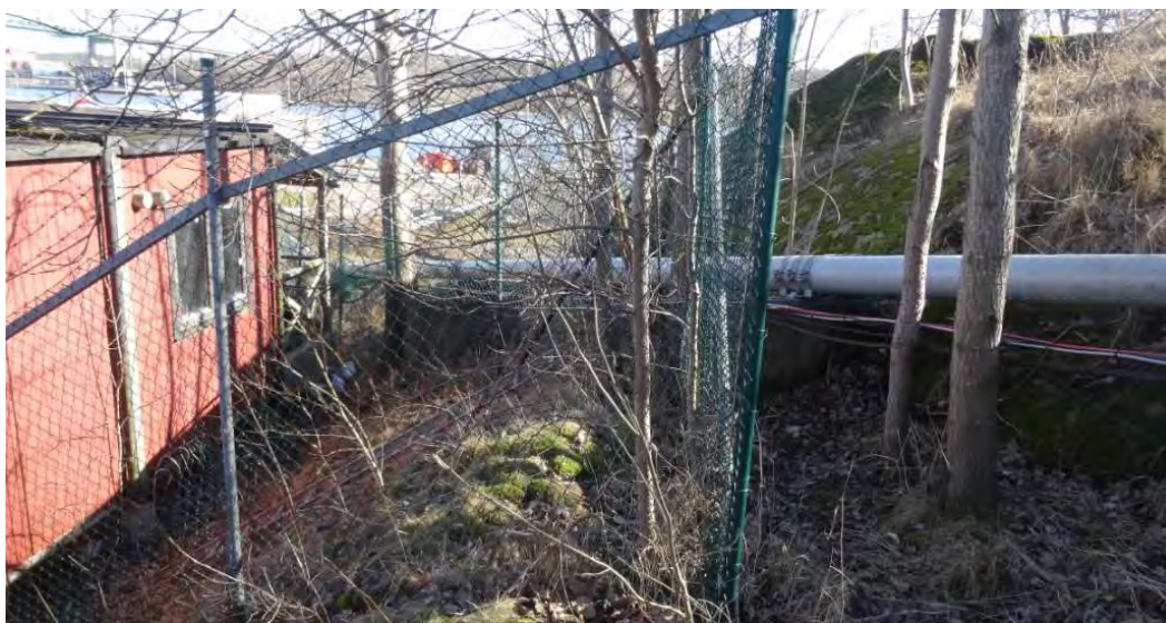
Bild 27 tagen mot norr där man ser flack slänt ner mot kontorsbyggnad/baracker. Inga stabilitetsproblem föreligger.
