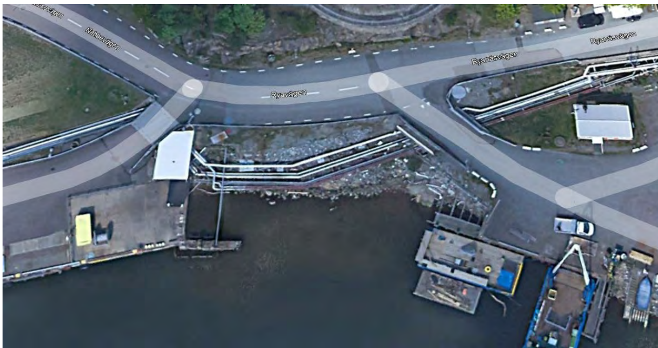
Bild 7 på östra delområdet där man ser ledningarna som anlagts i mitten.
