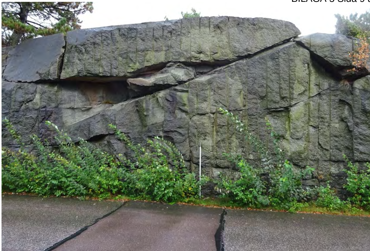
Bild 14 tagen på ställe S2 där man också kan ta bort mindre block. Stora blocket lär inte flytta sig då det är fastkilat.
