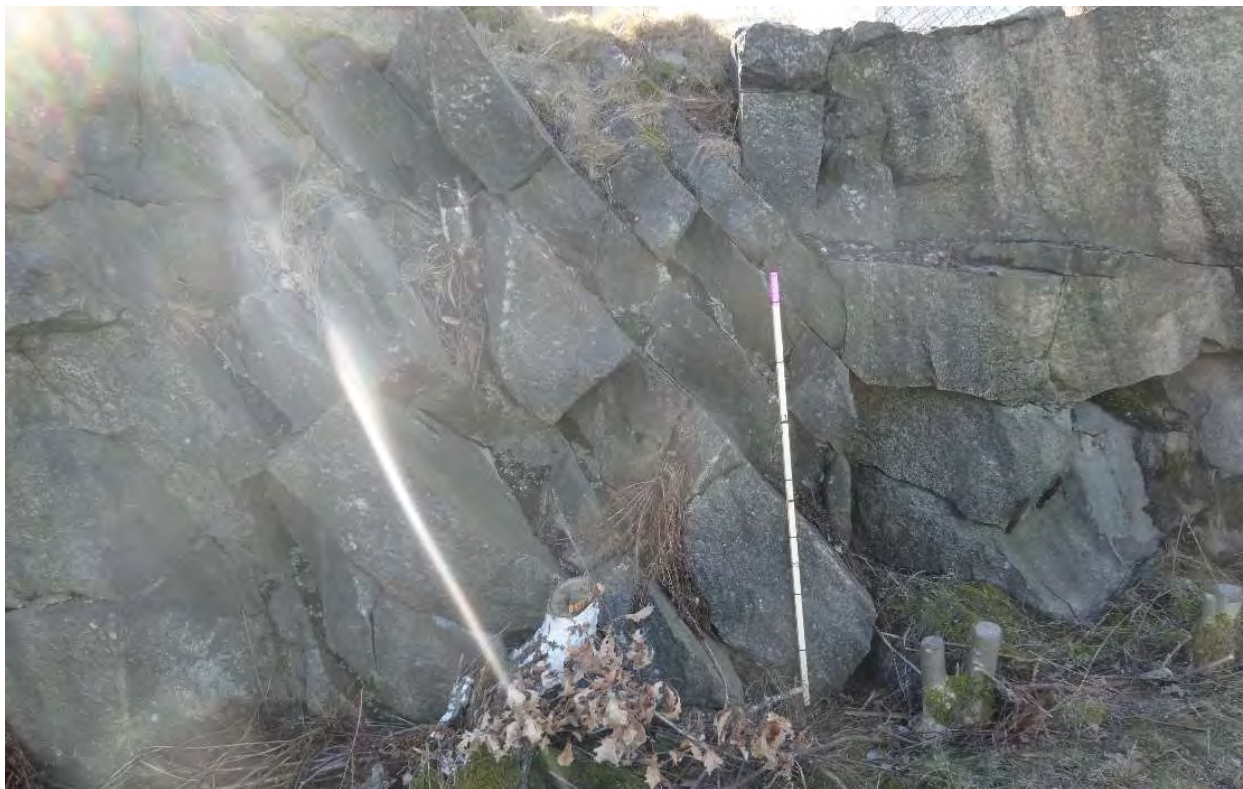
Bild 30 på mer uppsprucket berg där blocken ligger längs med sprickriktningen. Skärningshöjden är liten vilket innebär att inga större stabilitetsproblem kan uppstå ( förutsatt att man inte börjar utnyttja ytan mellan gatan och skärningen). Den flacka lutningen innebär att blocken är svåra att flytta.
