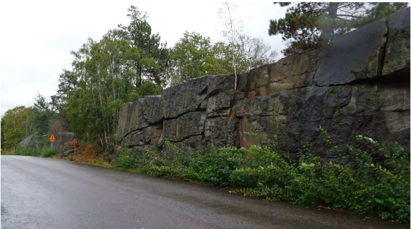
Bild 13 tagen mot norr längs med bergskärningen där man ser mycket stora block i det massiva berget.
