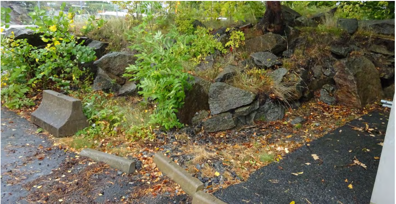
Bild 9 tagen på en del överskottsmassor (krossmaterial) som påförts området intill energibyggnaden. (Strax till höger om nummer 1 på planskissen.
