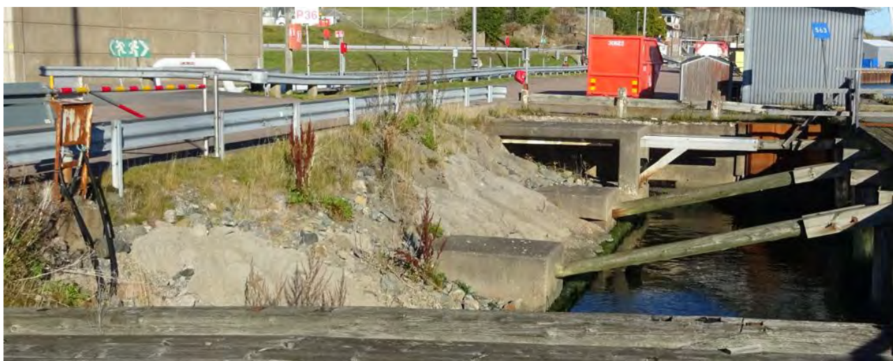
Bild 5 på samma område fast åt öster där man ser den relativt flacka lutningen och betongfundament som stödjer träbryggan till höger. Inga stabilitetsproblem bedöms föreligga.
