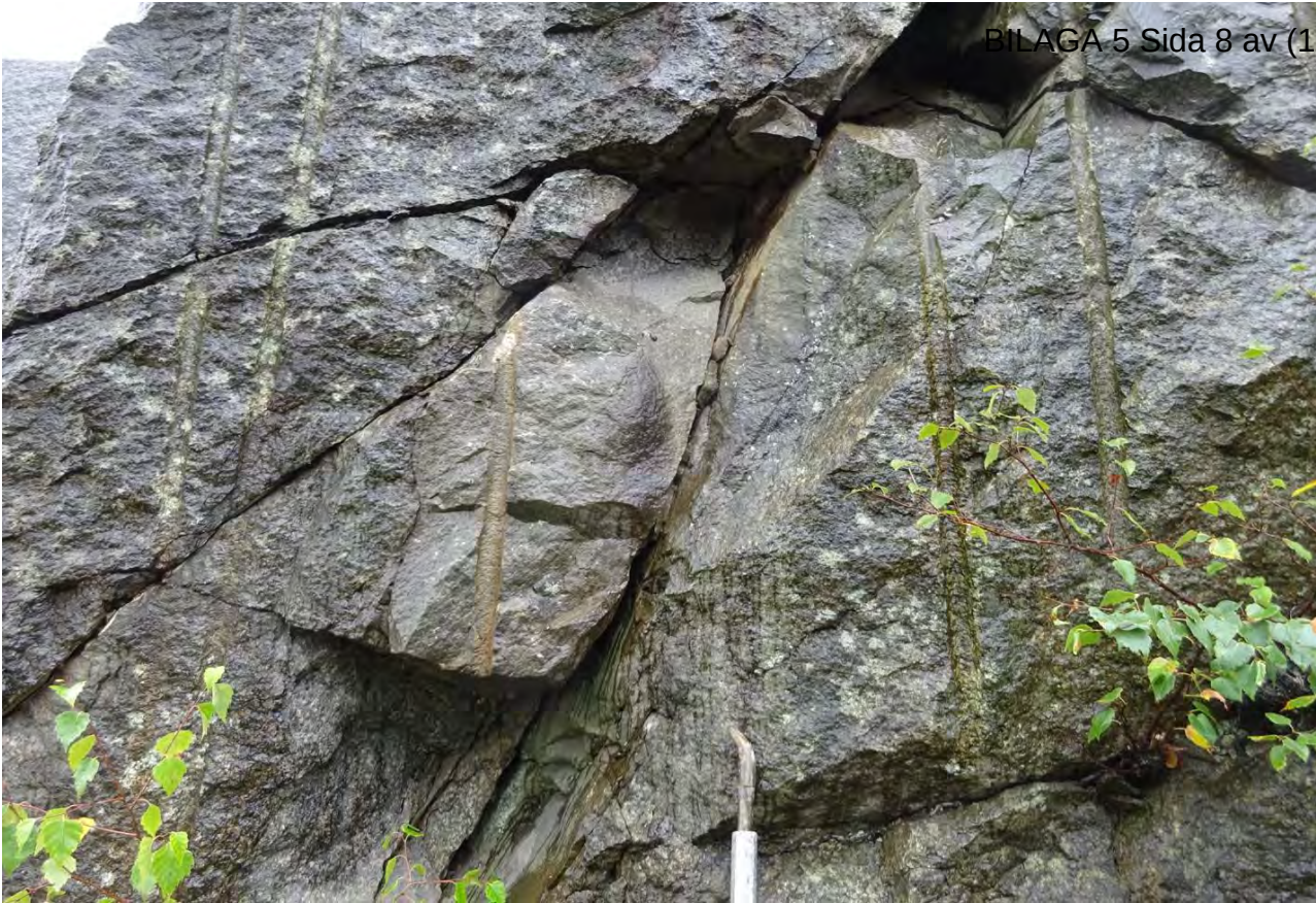
Bild 12 tagen på några mindre lösa block som kan ramla ner i det lilla diket med en del buskar. Enklare skrotning rekommenderas. Ungefärligt läge se planskiss (markerat S1) sista sidan i bilagan.
