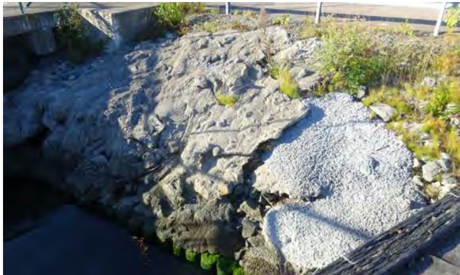
Bild 1 tagen från träbryggan på området längst i väster där man ser gröna träpålar och grovbetongen som låser fast krossmaterialet
