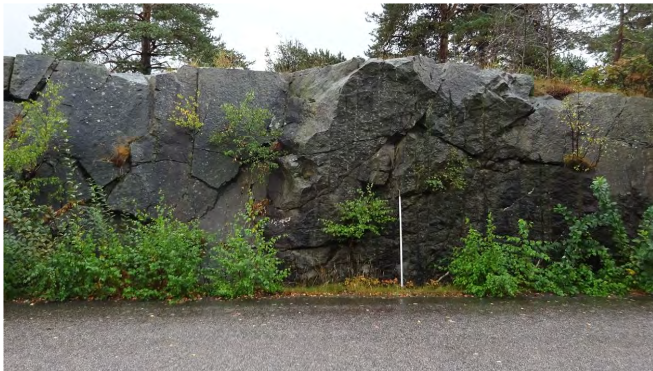
Bild 11 tagen bergskärningen som är ca 5 m hög och med relativt glest mellan sprickorna.
