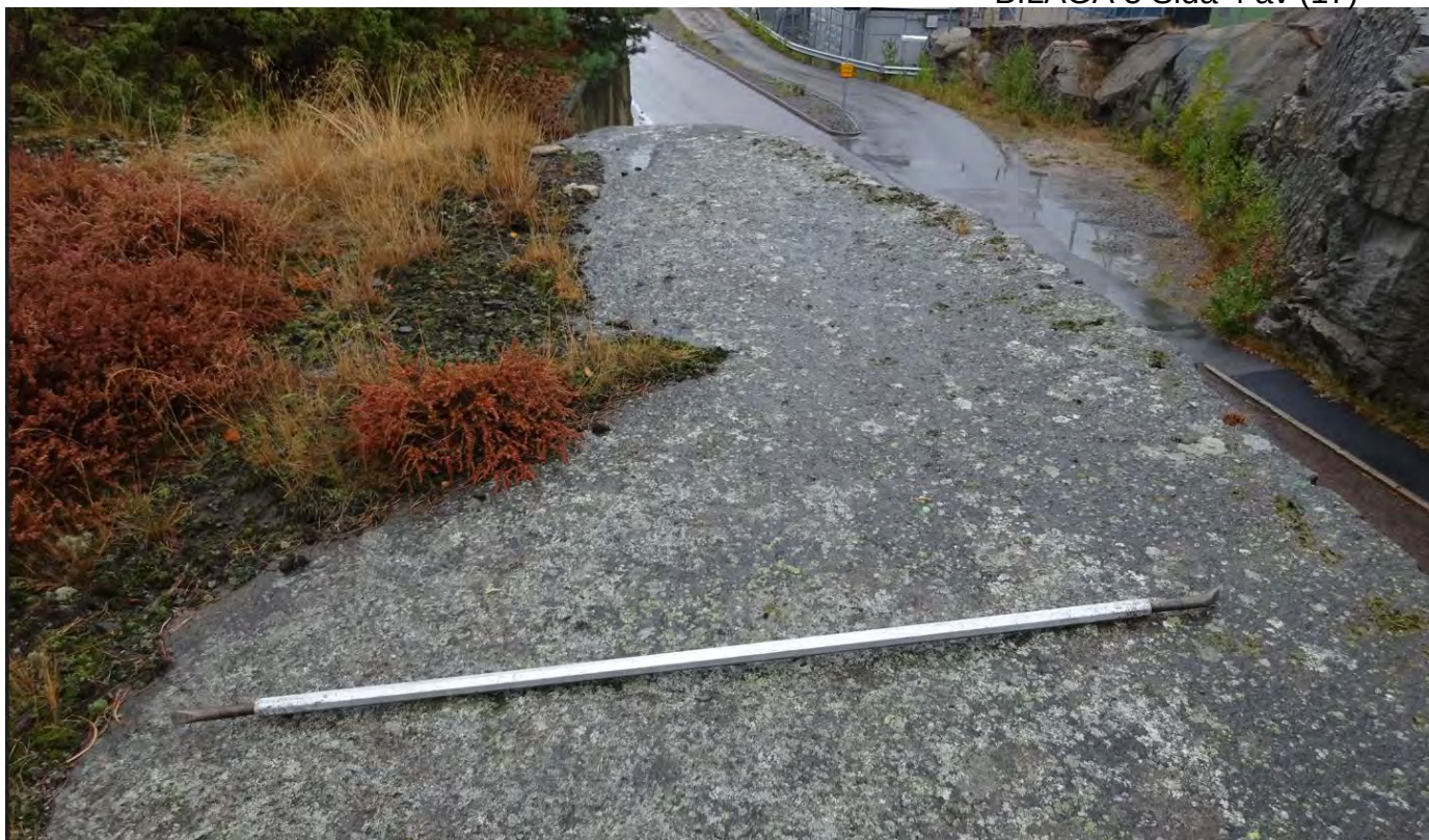
Bild 5 på plant avtäckt berg uppe på släntrön på östra sidan av Fågelvägen där man inte ser några sprickor på mer än 1,5 m längd som skrotspettet är 1,75 m långt.
