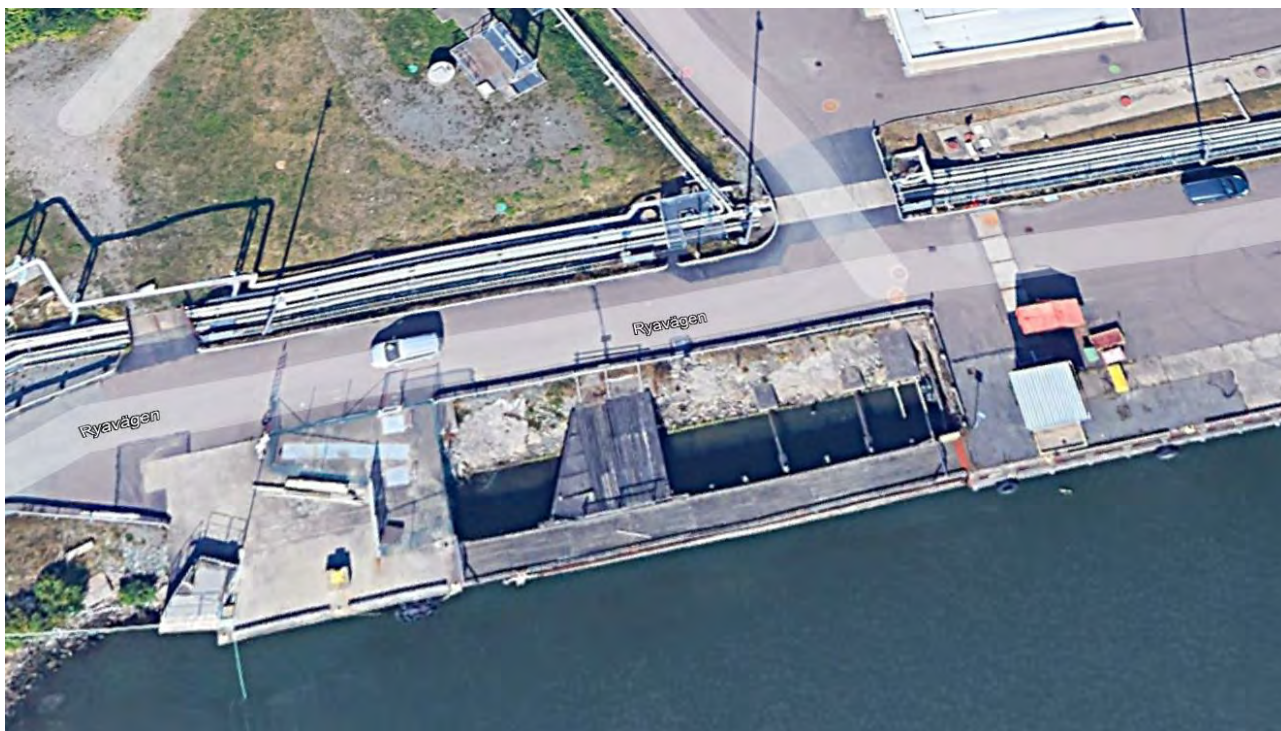
Bild 2 på delområde väster från Google Earth där man ser betongbrygga till vänster och en träbrygga i mitten som sen övergår till en betongbrygga längre österut (till höger).
