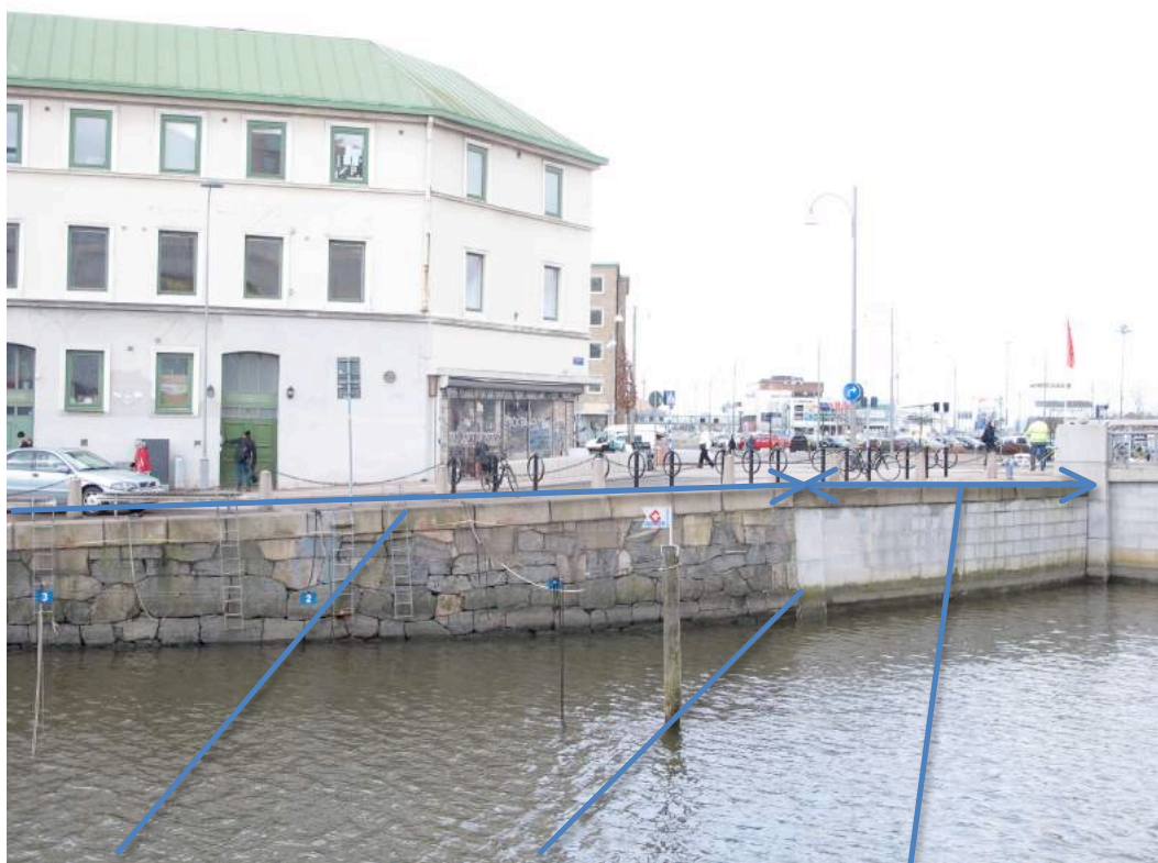
"Äldre kaj del" Övergång med betong under sten Nyare stensättning
