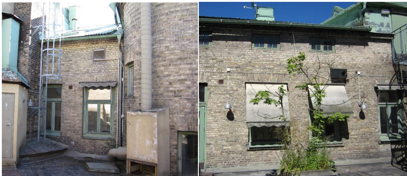
Figur 1 och 2 Innergård med fasader i handslaget tegel
