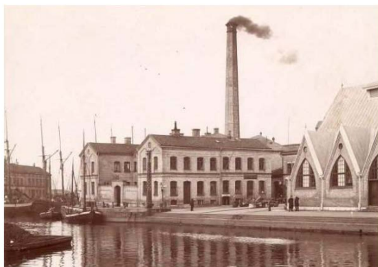
Ångkökets byggnad 1901 Ur "Göteborg under 300 år"
