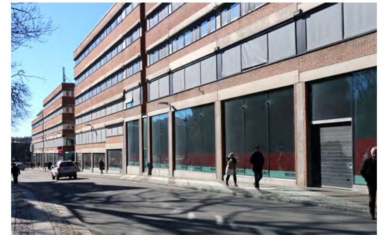
Under senare år har flertalet av stadens arkader byggts för. Här i kvarteret Rosenlund, förbyggt under 2014.
