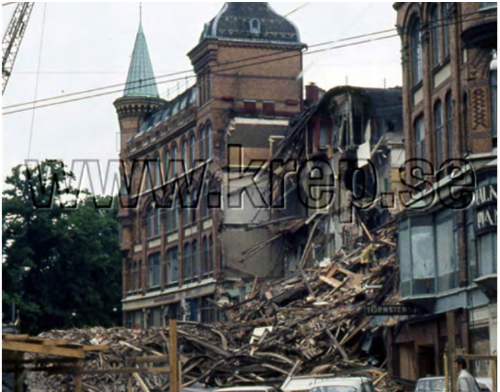
Rivning av Arkadenhuset, 1973. Foto: www.kamerareportage.se
