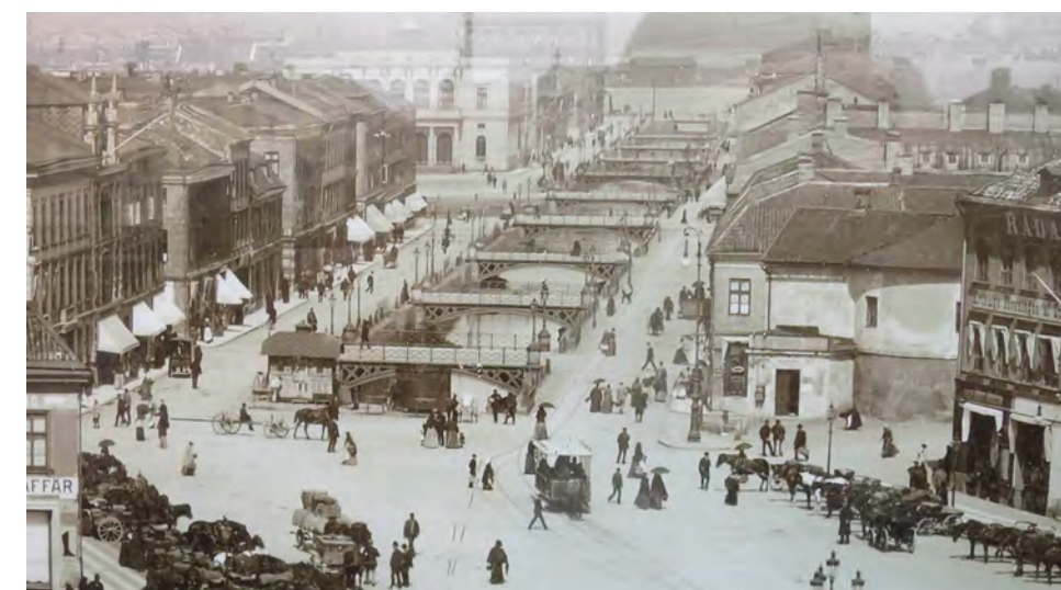
Före 1896. Utsikt från Stora Teatern mot norr
