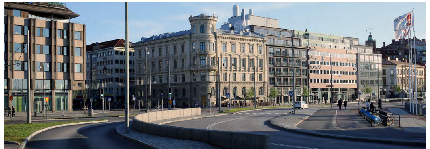
Fronten mot norr
