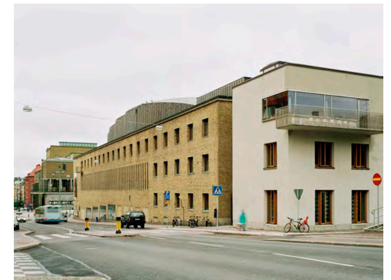
Tillbyggnaden till Göteborgs konserthus av White. Ett anpassat tillägg med ett tydligt eget uttryck men som anpassar sig i formspråk, volym och genom ett respektavstånd till den ursprungliga byggnadskroppen.
