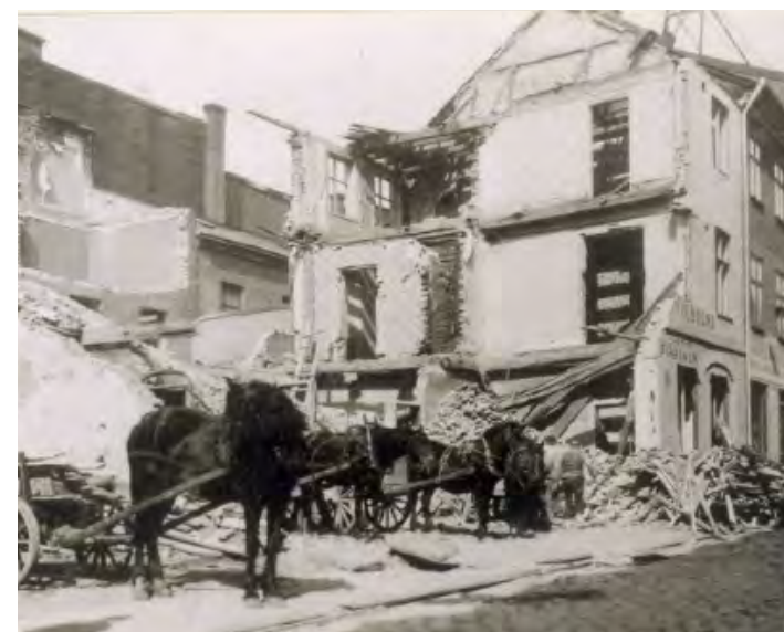
Rivning inför uppförandet av Arkaden. År 1898
