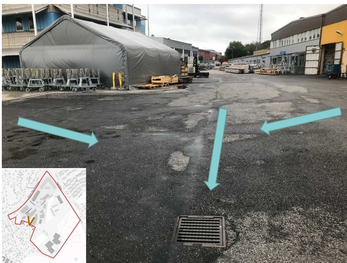
Figur 5. Vy av en rännstensbrunn vid området för en identifierad utloppspunkt. Större ledningsnät med dagvattenavledning finns belägen under denna plats.
