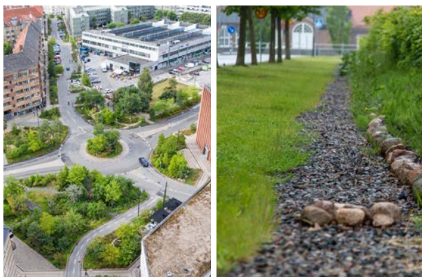
Bild: Till vänster: Bryggervangen och Skt. Kjellids Plads i Köpenhamn. Multifunktionell yta för dagvatten- och skyfallshantering: Bildkälla: (SLA, 2022) från Kretslopp och Vatten. Till höger: Dagvattenhantering i form av makadamdike i Mariastaden. Foto Lina Ekholm, Kretslopp och Vatten.
