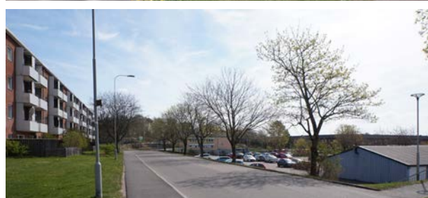
Bilder: Mörka gångtunnlar, större trafikapparater och öppna parkeringsytor. Att röra sig till och från Biskopsgården, men också mellan stadsdelens olika bostadsområden är att röra sig i utsatta miljöer där den upplevda otryggheten ofta är hög.
