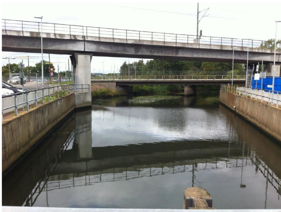
Figur 3: Gullbergsån vid utloppet för den mycket långa kulverten.
