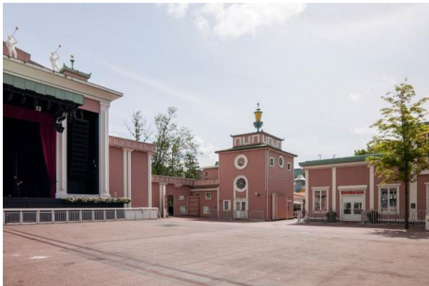
Figur 126. Det östra hörntornet vid spegeldammen.
