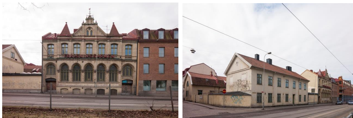
Figur 82 och 83. De två byggnaderna på fastighet Haga 30:1.
