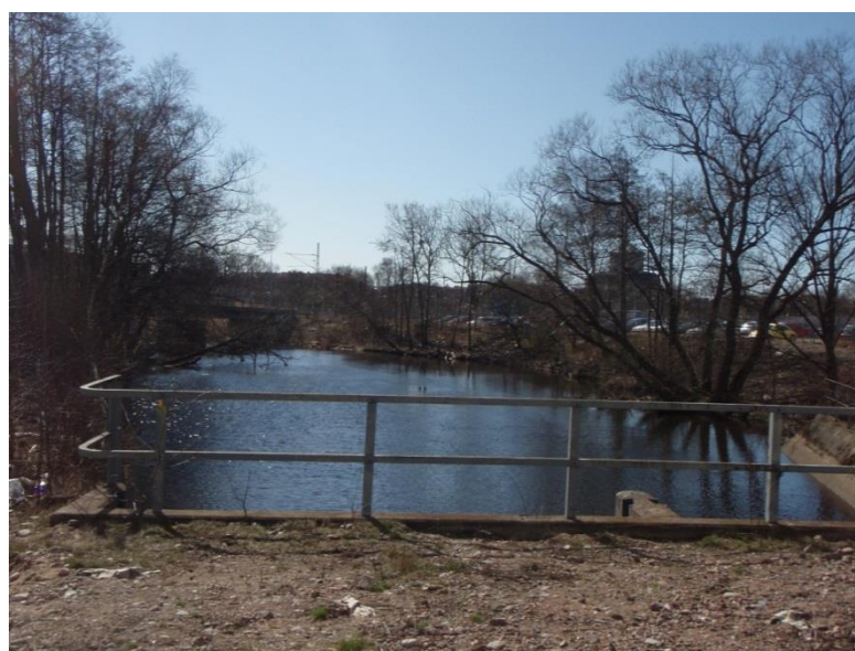
Figur 12 Växtlighet, strandskoning samt kulvertering under Partihallsgatan vid Gullbergsån (fotoriktning mot söder).
