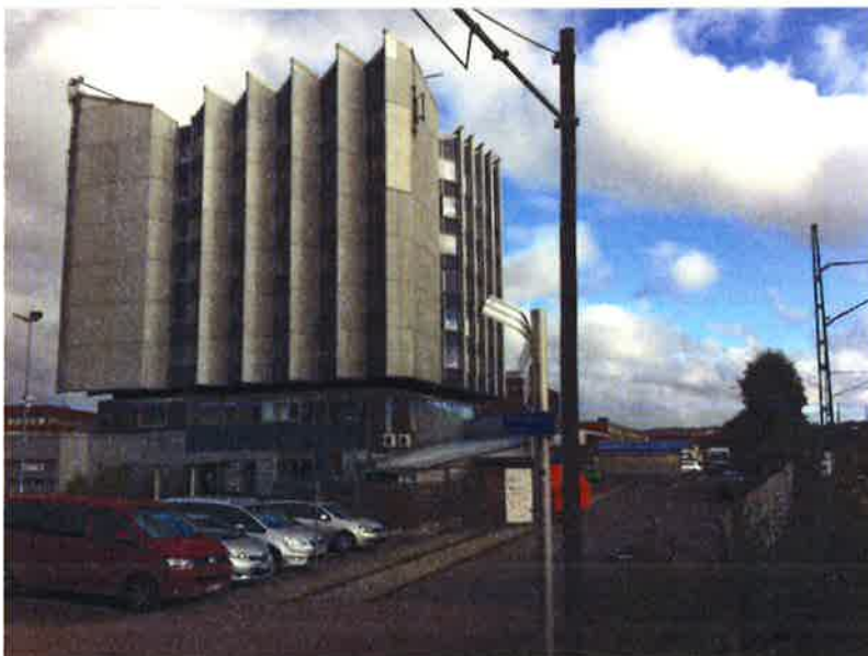
Byggnaden inom fastigheten Olskroken 35:17.
