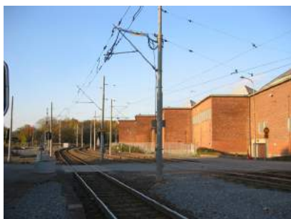
B27:s västra fasad
