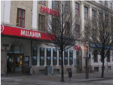
Kv. Bastionen, Göteborg, före ombyggnad
