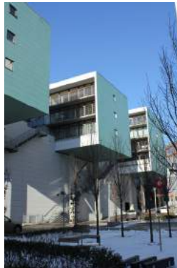
Påbyggnad med bostäder på P-hus, Göteborg
