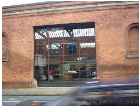
Nytt glasparti i äldre fasad, Manchester Princip 3
