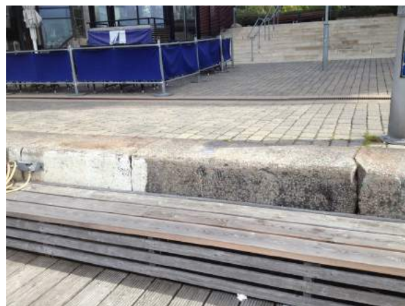
Enkel och industrimässig markbehandling Strandpromenaden, Västra Hamnen, Helsingborg
