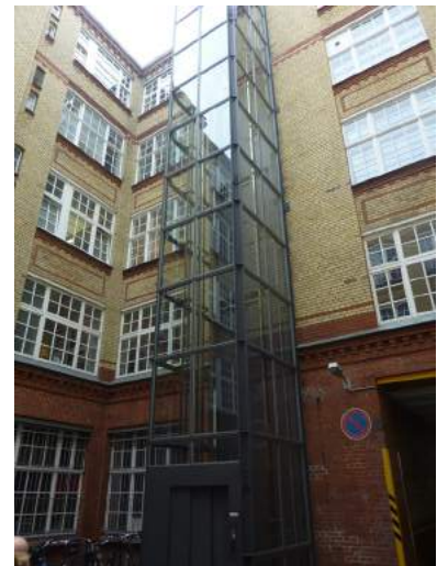
Moderna tillägg i stål och glas som fasadtillägg, Berlin. Princip 4
