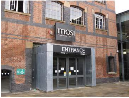
Ny entré som bryter mot det gamla, Manchester Princip 3
