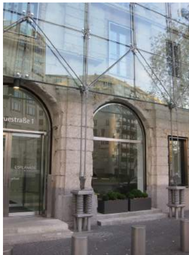
Ny glasfasad framför befintlig, Berlin Princip 4
