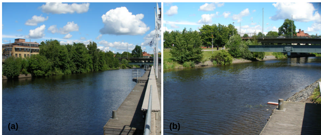
Figur 8 (a) Stödmurar och kajkonstruktioner (b) Erosionsskydd i form av sprängsten.
