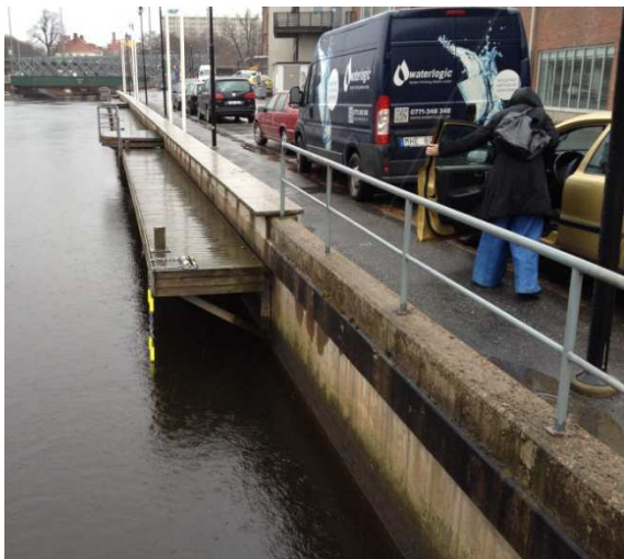
Betongkaj i bra skick
