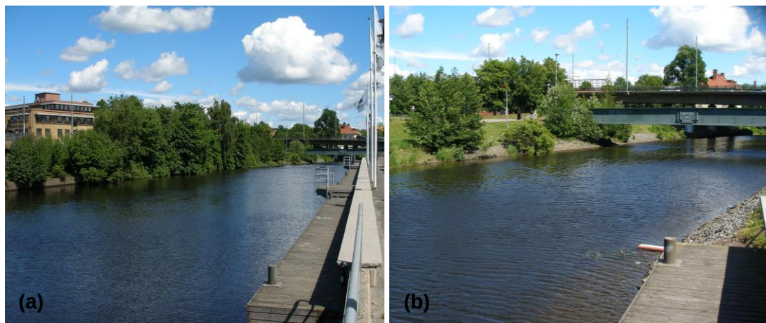
Figur 6 (a) Stödmurar och kajkonstruktioner (b) Erosionsskydd i form av sprängsten.
