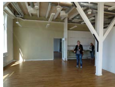
Foton från B13s interiör som bland annat visar en travers samt pelar-balksystemet.
